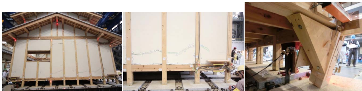
図 2.3.5-13 加振 E および F 後の外部の損傷観察
