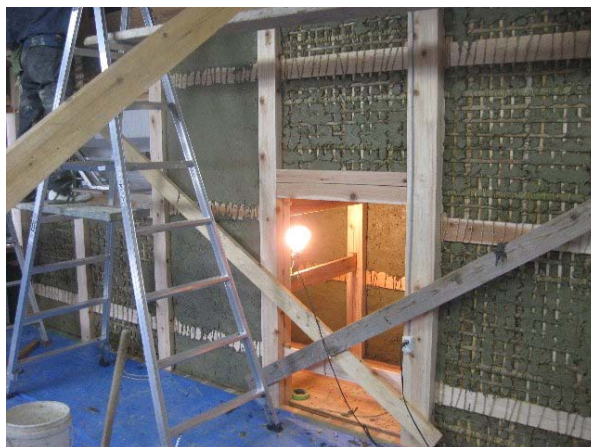
写真 2.1-5 荒壁塗り作業
