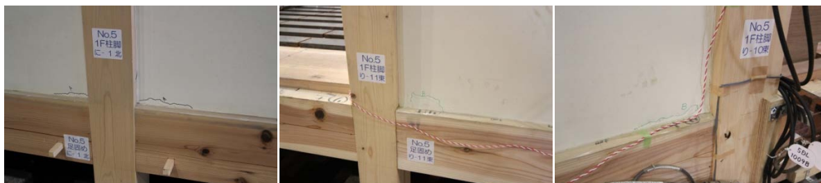
図 2.3.5-3 加振 A、加振 B 後の外部の損傷観察
