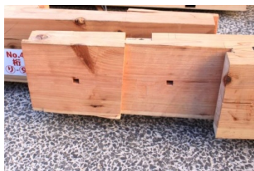
追掛大栓継ぎ目立つ損傷無し 写真 01 り通桁、5 通継手
