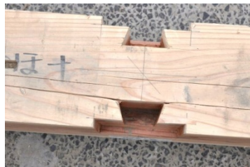
写真 05 ほ通中引き 10 通仕口
