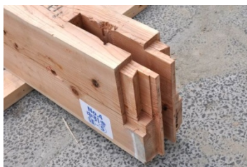
写真 04 ほ通中引き, 5 通継手
