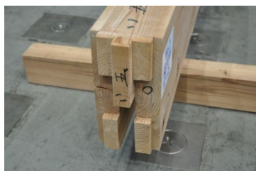
仕口部分損傷無し 写真 04 い通足固め、5 通端
