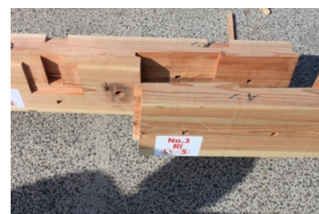
継手部分損傷無し 写真 03 い通桁, 5 通継手
