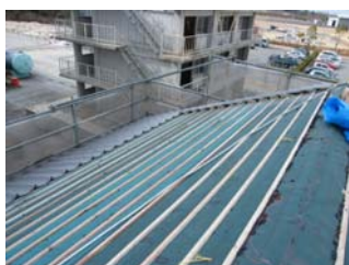
棧瓦部分、軒瓦部分損傷無し 写真 04 北面棧瓦解体
