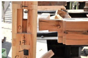
写真 08 ほ通足固め 1 通り仕口
