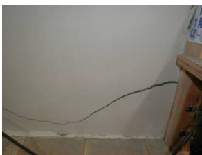
写真2 1階壁亀裂 ほ-8～9
