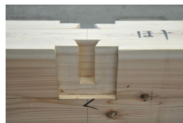
ささら仕口蟻掛け (ほ-10) 損傷無し 写真 03 ほ通中引き、9～13 通
