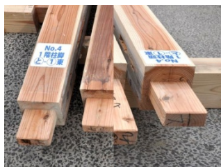
柱頭・柱脚共に目立つ損傷なし 写真 04 と-1, 1 階管柱
