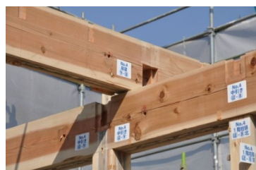
床梁仕口損傷無し 写真 01 9 通床梁, ほ通仕口
