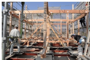
1通り側から構面ごとに解体する 写真 06 試験体 No. 4 軸組解体
