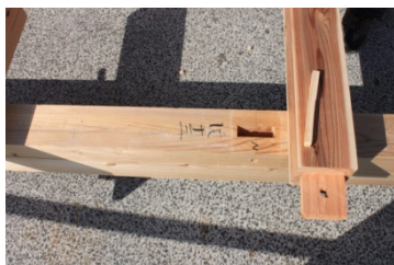
小屋束・仕口共傷無し 写真 01 に-13, 小屋束仕口
