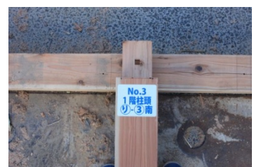
1階管柱柱頭ほぞ損傷無し 写真 07 リ-3, 1 階柱頭ほぞ
