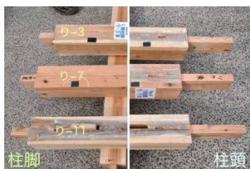
柱頭・柱脚の強軸方向から撮影 写真 04 り通り、1 階管柱
