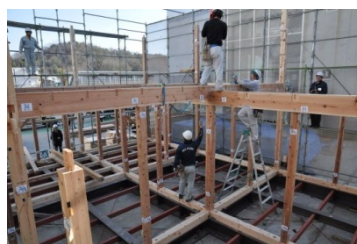
2階床根太ささらから胴差しへ 写真 03 試験体 No. 3 軸組解体
