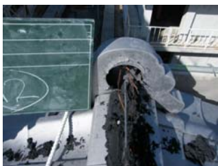
棟瓦、同内部に損傷無し 写真 02 13 通側、棟瓦解体
