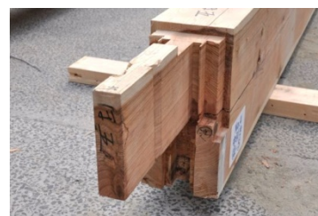
写真 03 ほ通中引き, 5 通継手
