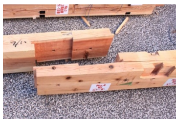
入隅部分から亀裂が生じる 写真 01 い通桁, 9 通継手
