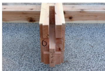
胴差し仕口、損傷無し 写真 06 13 通胴差し, り通端
