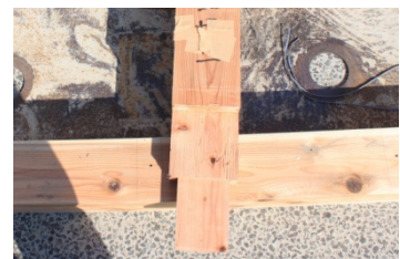
2階管柱柱脚ほぞ損傷無し 写真 07 ほ-3 柱脚ほぞ
