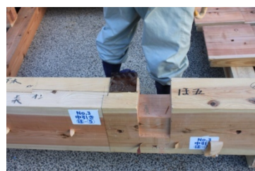
中引き仕口、損傷無し 写真 04 ほ通中引き、ほ-5 仕口
