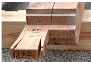
足固め小根ほぞ割くさび亀裂拡大 写真 07 り通足固め 13 通り仕口
