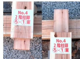
柱頭・柱脚共に目立つ損傷なし 写真 03 ろ-1 2 階管柱
