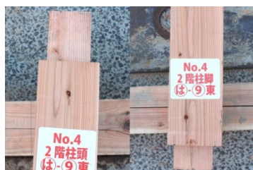
柱頭・柱脚共に目立つ損傷無し 写真 02 は-9, 2 階管柱
