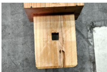
ハ-13 柱脚、ほぞ亀裂 写真 01 ハ-13 管柱脚ほぞ亀裂
