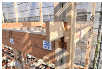
柱仕口, 胴差し目立つ損傷はない 写真 02 ほ-1 通し柱・雇い
