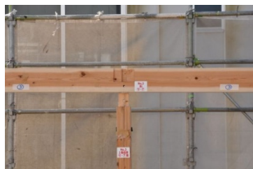
小屋束・仕口共傷無し 写真 01 り通桁, リ-7 仕口
