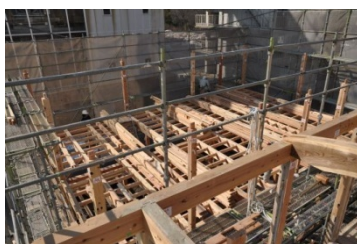
2階管柱より上部の解体が終了 写真 02 試験体 No. 3 軸組解体
