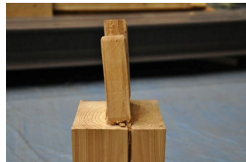
床束ほぞ折損 (写真 08 と直交方向) 写真 09 ト-9, 床束ほぞ
