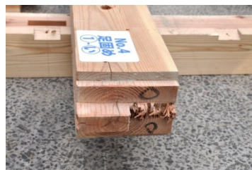
足固め小根ほぞ折損 写真 05 い-1, 足固め
