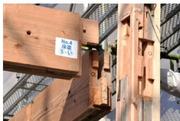
床梁、胴差し仕口は損傷無し 写真 02 い-5, 2 階, 通し柱
