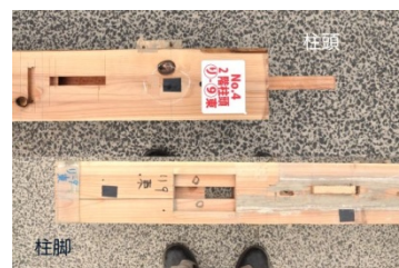
柱頭・柱脚・2 階仕口目立つ損傷無し 写真 03 り-9, 通し柱
