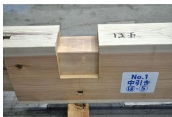
渡りあご仕口、上下部材共損傷無し 写真 02 ほ通中引き、5～9 通
