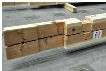
込み栓部分を通る乾燥割れ拡大 写真 04 ホ通中引き, 9 通端
