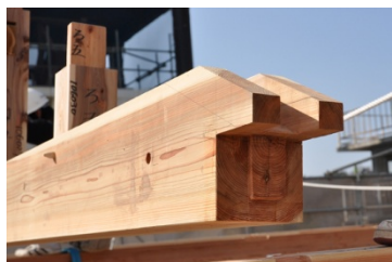
小屋束・仕口共傷無し 写真 01 5 通小屋梁い通仕口
