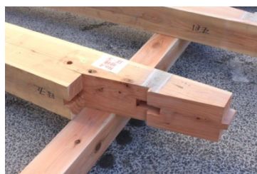
写真 01 ほ通地棟, 5 通継手
