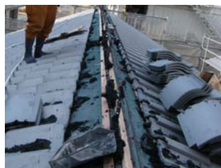
棟瓦、同内部に損傷無し 写真 03 棟瓦解体
