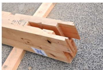
ほ通竿車知栓継女木損傷無し 写真 05 ほ-5, 床張り継手
