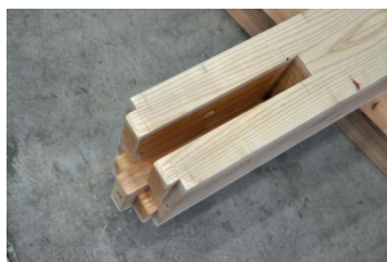
仕口部分損傷無し (下端撮影) 写真 05 い通足固め、5 通端
