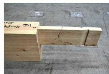
竿中央部の折損 写真 05 い-1, 竿引き独鈎折損
