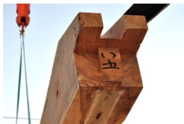
小屋梁兜蟻仕口損傷無し 写真 01 5 通小屋梁い通端
