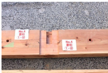
妻桁・小屋束損傷無し 写真 01 妻桁い〜り間
