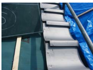
棧瓦部分、軒瓦部分損傷無し 写真 04 北面軒瓦解体
