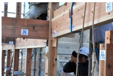
解体中の仕口部分を撮影する 写真 07 損傷観察方法 01
