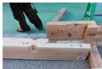
追掛け大栓継損傷無し 写真 06 ほ通中引き、ほ-9 継手
