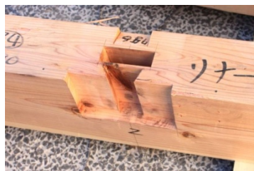
兜蟻、2 階管柱ほぞ仕口損傷無し 写真 02 り通桁、小屋梁仕口
