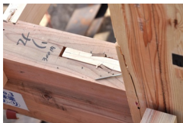
雇い、車知栓解体前の状況 写真 02 9 通床梁, り通端
