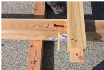
妻桁・小屋束損傷無し 写真 01 妻桁ほ～り間
