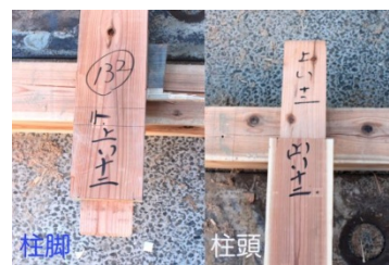
柱頭・柱脚目立つ損傷無し 写真 03 い-12, 2 階管柱
