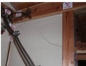
写真6 2階壁亀裂 い-12～13
