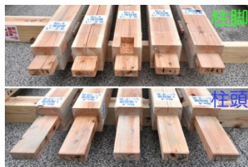
柱頭・柱脚目立つ損傷無し 写真 04 い通り、1 階管柱
