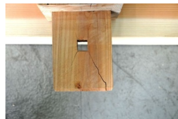
柱脚ほぞのほぞ穴部分からの亀裂 写真 06 は-13 柱脚ほぞの亀裂
