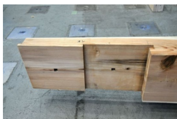
追掛大栓、継手上木下木共損傷無し 写真 01 ほ通中引き、5 通端
