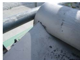
巴瓦目欠け 写真 03 1 通側巴瓦
