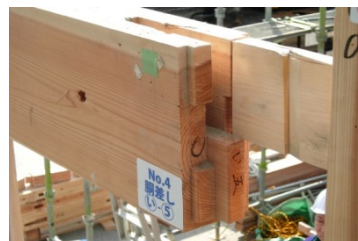
写真 06 い-5. 胴差し仕口
