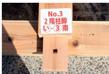
2 階管柱柱脚ほぞ損傷無し 写真 05 い-3 2 階柱脚ほぞ
