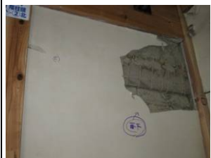
写真4 1階壁剥落 い-1～2
