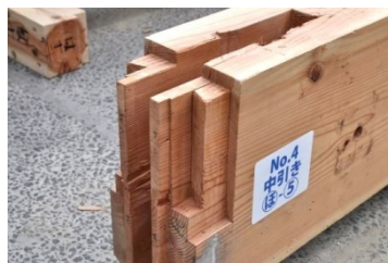
各仕口などを拡大して撮影 写真 09 損傷観察方法 03
