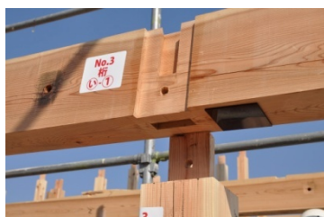
い-1 以外桁仕口で損傷無し 写真 01 い通桁, い-3 仕口
