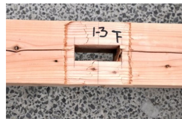
足固めめり込み亀裂, 床束の折損 写真 06 ろ-1, 足固め・床束
