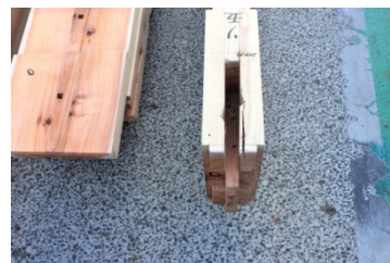
仕口部分は目立った損傷無し 写真 03 5 通床梁、り通端
