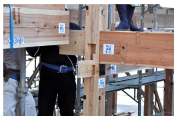
胴差し仕口, 雇い等損傷無し 写真 04 い通, 通柱, 胴差し解体
