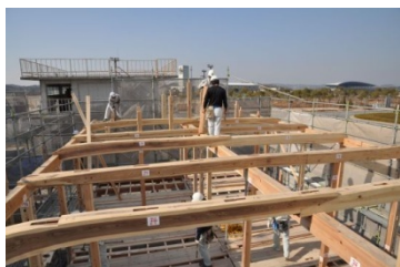
小屋組の解体が終了 写真 04 試験体 No. 4 軸組解体
