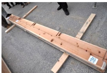
部材毎にラベルを含み全体撮影 写真 08 損傷観察方法 02
