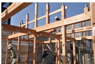
小屋組から小屋梁、地棟と進む 写真 01 試験体 No. 3 軸組解体
