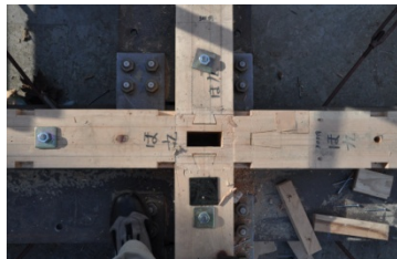
土台、蟻部分男木女木に損傷無し 写真 08 ほ通土台、ほ-9 継手
