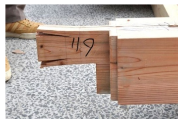
柱脚足固め小根ほぞ損傷無し 写真 06 り-9, 足固め仕口
