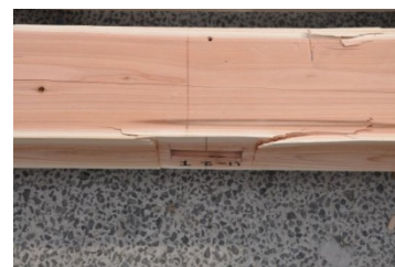
床束ほぞの圧壊・亀裂(側面撮影)
