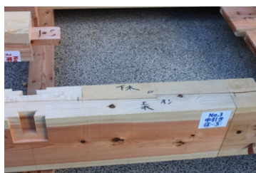
追掛け大栓継損傷無し 写真 05 ほ通中引き、ほ-5 継手
