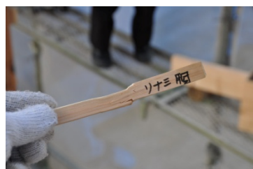
胴差し込み栓めり込み 写真 04 リ-13 胴差しほぞ
