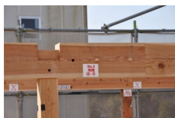
地棟仕口で損傷無し 写真 01 ほ通地棟、ほ-9 仕口
