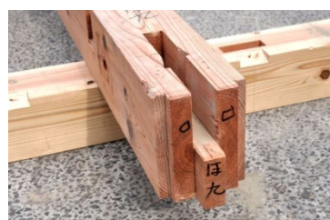
足固め竿車知栓継女木損傷無し 写真 07 ほ-9, 足固め仕口
