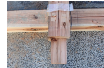
1階管柱柱脚ほぞ損傷無し 写真 09 ほ-3 柱脚ほぞ
