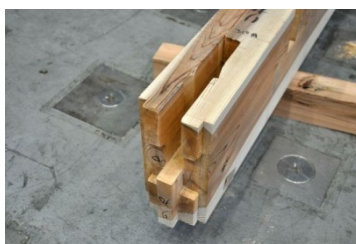
足固めの両端仕口は傷無し 写真 02 9通足固め, り通端
