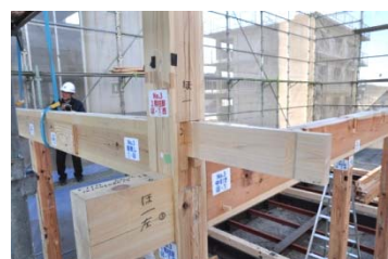
胴差し通し柱仕口、損傷無し 写真 07 1通-ほ, 胴差し
