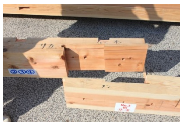
追掛け大栓継損傷無し 写真 02 り通桁, 5 通継手
