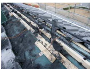
棟瓦、同内部に損傷無し 写真 02 棟瓦解体
