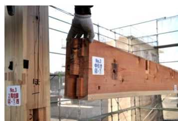
中引き端部仕口で損傷無し 写真 03 ほ通中引き、ほ-1 仕口
