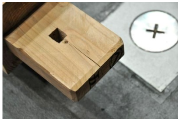
リ-7 柱脚、ほぞ穴下より亀裂 写真 01 リ-7 管柱脚ほぞ亀裂
