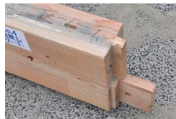
包込ほぞ差し込み栓打、損傷無し 写真 03 り-1 胴差し、仕口
