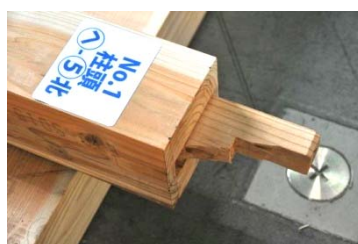
～5 柱頭、ほぞ折損 写真 02 へ～5 柱頭ほぞ折損
