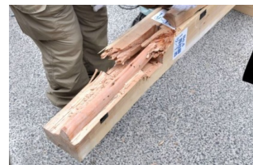
割れに沿って材を剥いだ様子 写真 09 り-1, 通し柱柱脚(西)
