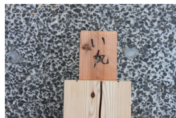
柱頭ほぞは損傷無し 写真 09 い-9 柱頭ほぞ
