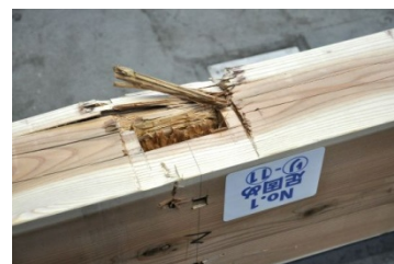
床束めり込み割れ (下端撮影) 写真 06 り通足固め、り-5
