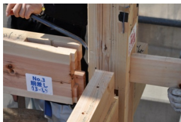
胴差し 雇い解体時の状況 写真 02 13 通胴差し, い通端
