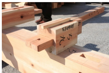
小屋束・仕口共傷無し 写真 01 ち-9, 小屋束仕口
