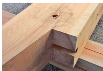
写真 02 ほ通地棟, 5 通継手
