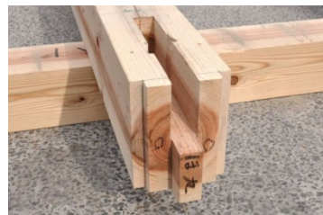
写真 06 ほ通足固め 9 通り仕口
