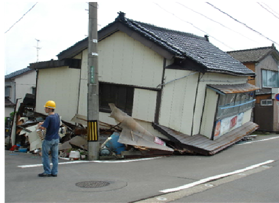
写真 3.5.1 地震で1階が崩壊した木造建物の被害例
