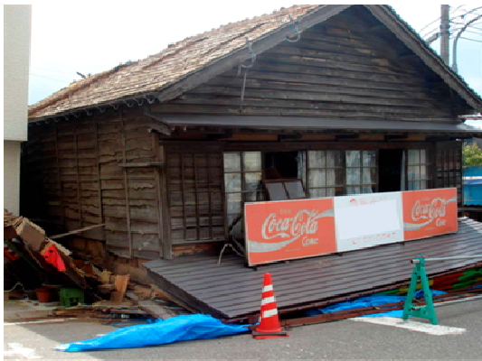
写真 3.5.1 地震で1階が崩壊した木造建物の被害例
