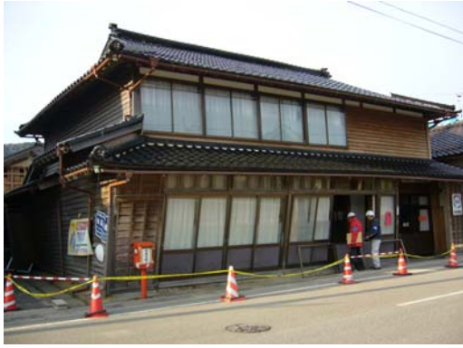
写真 3.5.2 地震で1階が大きく変形した木造建物の被害例
