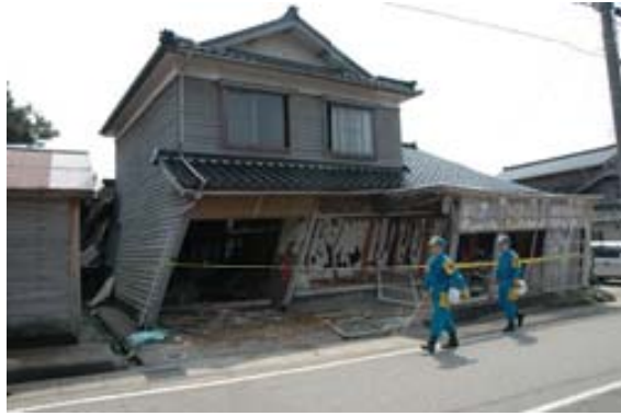
写真 3.5.2 地震で1階が大きく変形した木造建物の被害例
