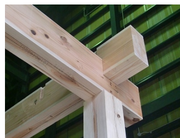
(i) 桁の接合部
