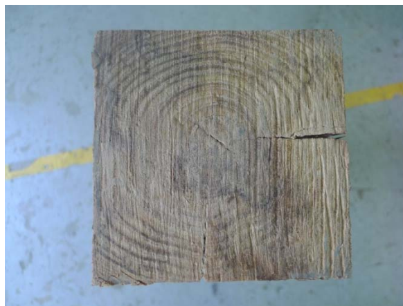
写真 4. 2. 1-13 礎石・細 柱底面
