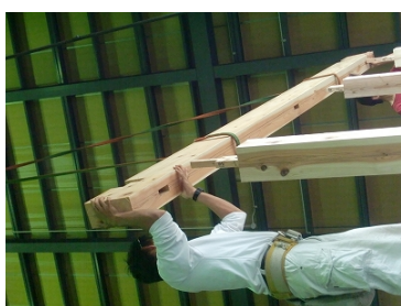
(d) 桁-柱接合部
