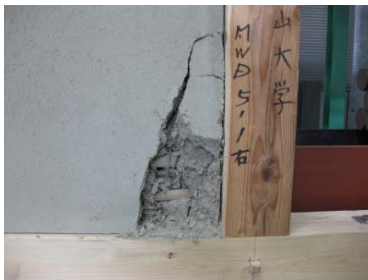
(a) 下側隅角部 (MWD5-1)
