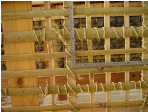
小舞間隔 (空き 40 mm 角：縦 70×横 70mm)
