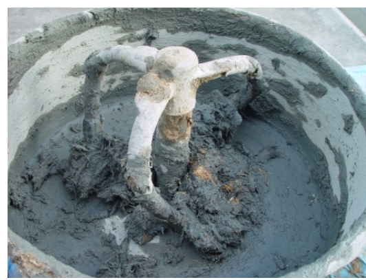
中塗土の練混ぜ(もみスサの混入)
