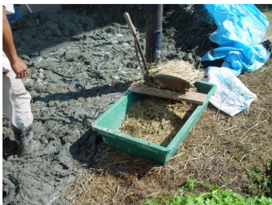
スサの混入と押切りによる切断
