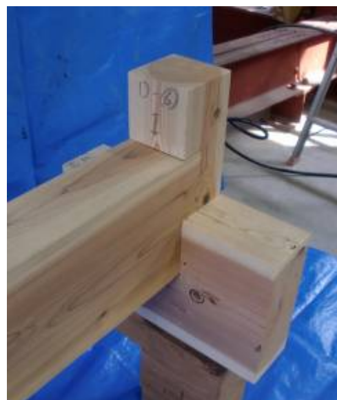
写真 4. 6. 3-2 仕口組立状況
