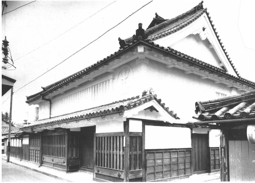
写真 5.4.3 -1 豊田家住宅 奈良県橿原市今井町 寛文 2 年（1662） 『重要文化財 豊田家住宅修理工事報告書』奈良県教育委員会 昭和 51 年刊
