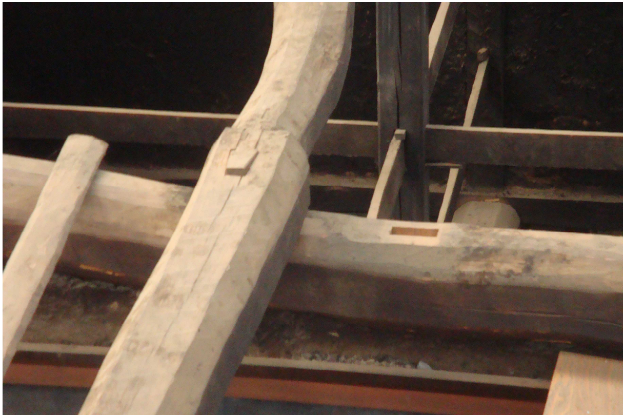
写真 5.5.2-2 重要文化財小野家住宅（長野県塩尻市） 小屋梁継手・仕口
