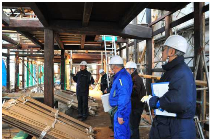
写真 5.5.4-1 現地調査 重要文化財大村家住宅（愛媛県内子町）
