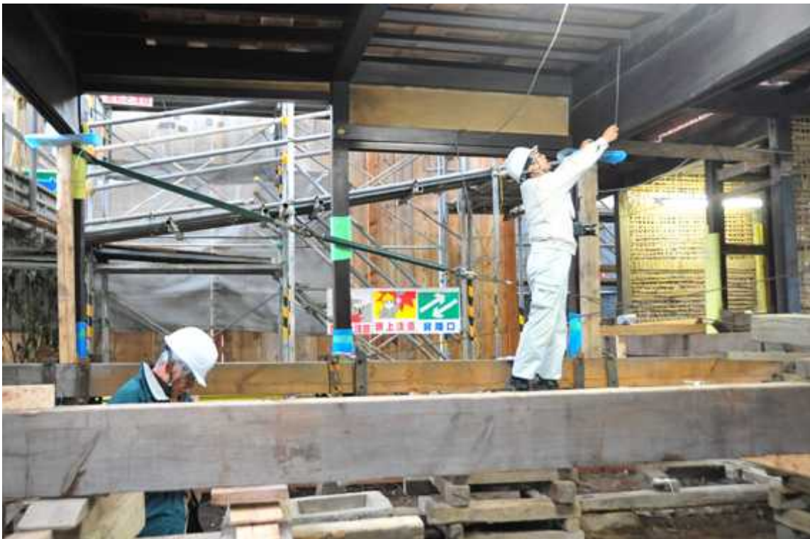
写真 5.5.2-1 現地調査 重要文化財小野家住宅 (長野県塩尻市)
