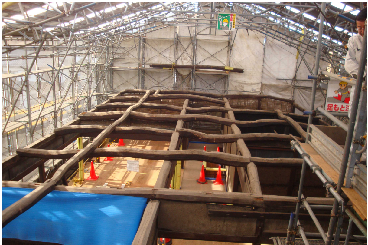
写真 5.5.2-3 重要文化財小野家住宅（長野県塩尻市） 小屋梁架構
