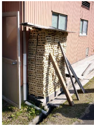
B.込み栓材料の屋外棧積み乾燥
