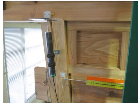
写真 6. 3. 1-3 柱頭の割裂と受け材による損傷
