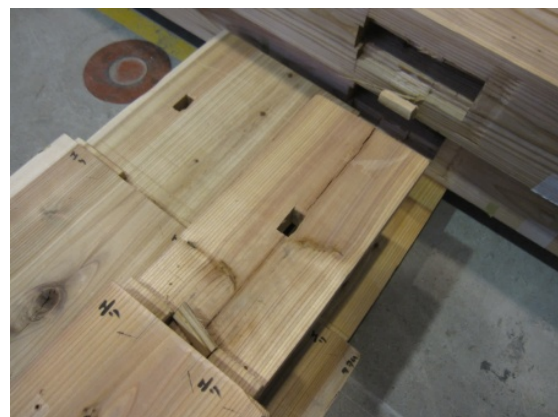
写真 6. 3. 1-5 差し鴨居接合部の損傷
