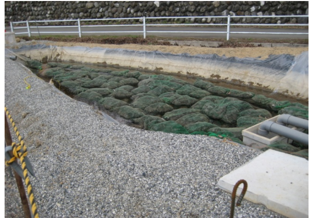
写真 6.4.3-22 浄化用池の木炭の施工状況
