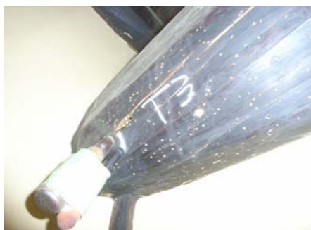
写真 6. 6. 2-25 小屋梁のシロアリおよび甲虫類による食害
