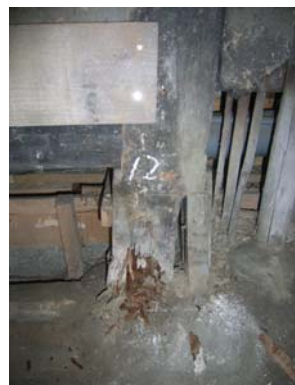
写真 6. 6. 2-28 台所土間の柱のシロアリ食害と腐朽
