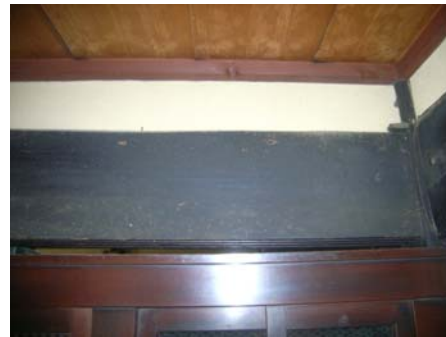
写真 6. 6. 2-8 同上差鴨居に発生した亀裂（左）と甲虫類による食害痕跡（右）
