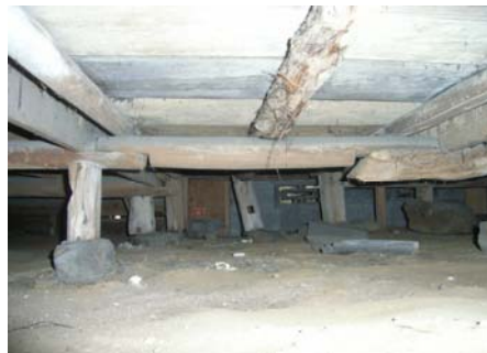
写真 6. 6. 2-27 床下の状況とシロアリ食害
