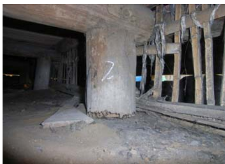
写真 6. 6. 2-27 床下の状況とシロアリ食害
