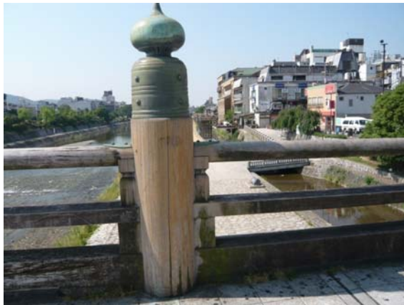
写真 6. 6. 4. -6 三条大橋の銅擬宝珠付きの木製支柱
