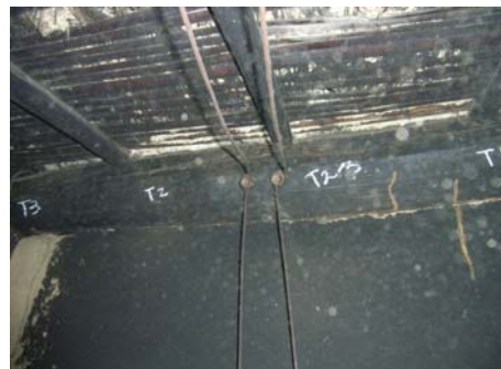
写真 6. 6. 2-25 小屋梁のシロアリおよび甲虫類による食害
