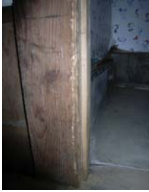
写真 6. 6. 2-11 浴室入口柱の蟻道（左）、床束の蟻道（中）、基礎の蟻道（右）
