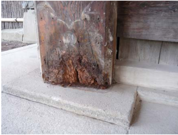
写真 6. 6. 4. -12 松本城の門柱
