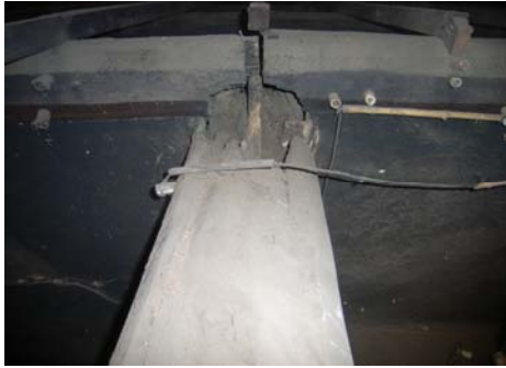
写真 6. 6. 2-1 大黒柱上端と梁との交差部における虫害と腐朽の状況
