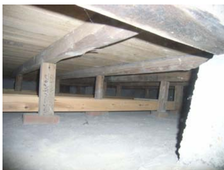
写真 6. 6. 2-18 床下の状況（乾燥している）
