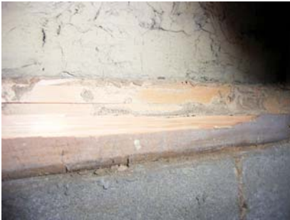
写真 6. 6. 2-12 土台のシロアリ食害（左）、束・大引接郷部の食害（中）、 床下土壌の水分による基礎の水シミの状態（右）
