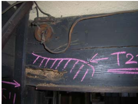
写真 6. 6. 2-7 大黒柱と北側差鴨居のシロアリ食害（左：東面、右：西面）
