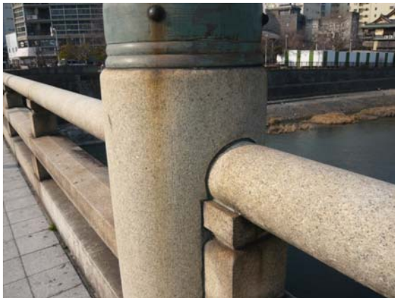
写真 6. 6. 4. -8 五条大橋の石材支柱と石材横木の接合部
