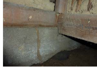
写真 6. 6. 2-11 浴室入口柱の蟻道（左）、床束の蟻道（中）、基礎の蟻道（右）
