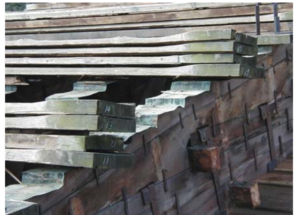
写真 6. 6. 4-11 床版の下桁太の階段状銅板カバー
