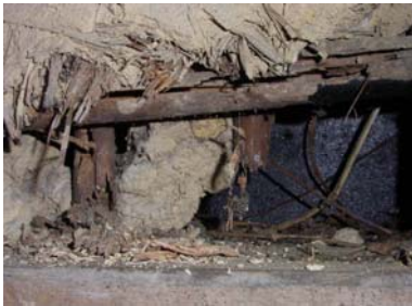
写真 6. 6. 2-13 床下・小舞竹の蟻害（左）、大黒柱（中）、小屋裏・妻面（右）の様子
