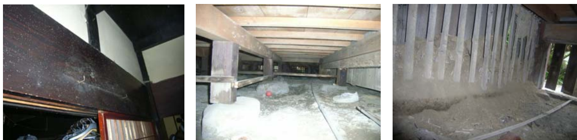
写真 6. 6. 2-16 差鴨居の甲虫類の食害と床下の状況
