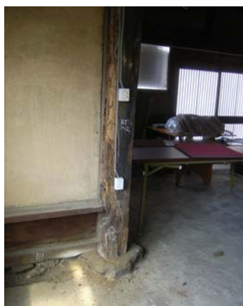
写真 6. 6. 2-26 玄関土間の柱など構造部材のシロアリ食害
