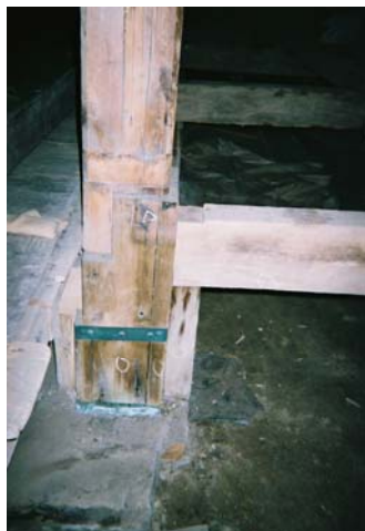
写真 6. 6. 2-17 床下部材への銅板の施工状況
