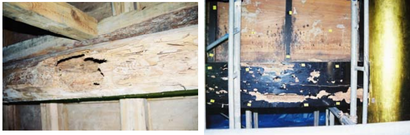
写真 6. 6. 1-2 寺院本堂内の床下で長期間にわたり拡大した生物劣化 ヤマトシロアリ被害が内陣来迎壁にまで及んでいる（右）（富山県、重文）
