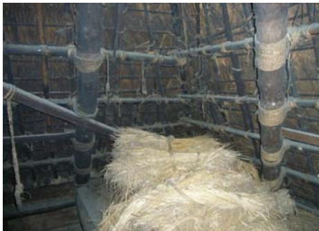
写真 6. 6. 2-3 小屋裏の状態
