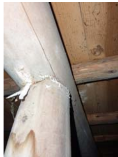
写真 6. 6. 2-12 土台のシロアリ食害（左）、束・大引接郷部の食害（中）、 床下土壌の水分による基礎の水シミの状態（右）
