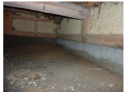
写真 6. 6. 2-12 土台のシロアリ食害（左）、束・大引接郷部の食害（中）、 床下土壌の水分による基礎の水シミの状態（右）
