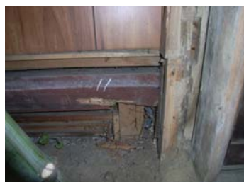
写真 6. 6. 2-28 台所土間の柱のシロアリ食害と腐朽
