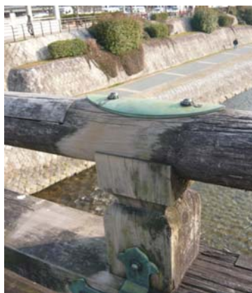
写真 6. 6. 4-3 左岸付近の欄干
