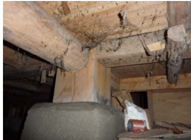
写真 6. 6. 2-13 床下・小舞竹の蟻害（左）、大黒柱（中）、小屋裏・妻面（右）の様子
