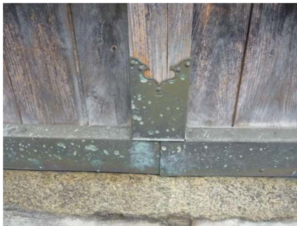
写真 6. 6. 4-16 与謝町民家の土台
