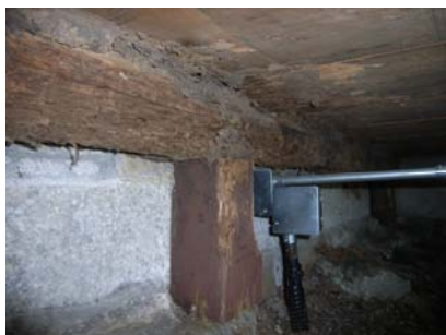
写真 6. 6. 2-23 床下の腐朽と蟻害の発生状況（1）
