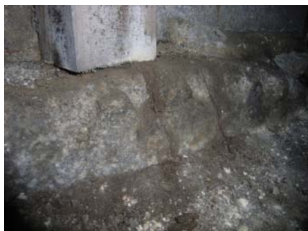
写真 6. 6. 2-24 床下の腐朽と蟻害の発生状況（2）
