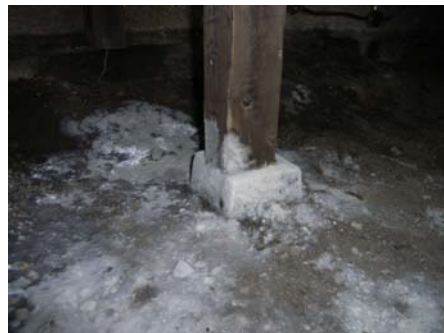
写真 6. 6. 2-24 床下の腐朽と蟻害の発生状況（2）
