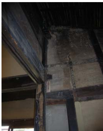
写真 6. 6. 2-26 玄関土間の柱など構造部材のシロアリ食害
