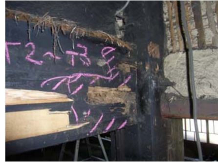
写真 6. 6. 2-7 大黒柱と北側差鴨居のシロアリ食害（左：東面、右：西面）
