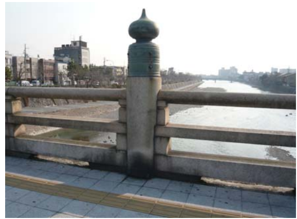
写真 6. 6. 4. -7 五条大橋の銅擬宝珠付きの石材製支柱
