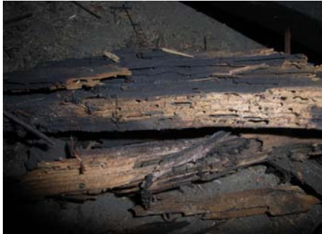
写真 6. 6. 2-2 大黒柱上端に連結する桁材における甲虫類による食害（左）と腐朽（右）
