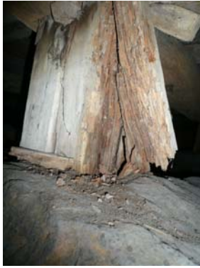
6. 6. 2-6 床束の腐朽（左）と大黒柱の足元における結露水によるシミ・腐朽（右）
