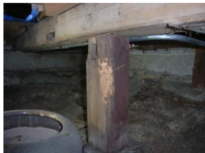
写真 6. 6. 2-23 床下の腐朽と蟻害の発生状況（1）
