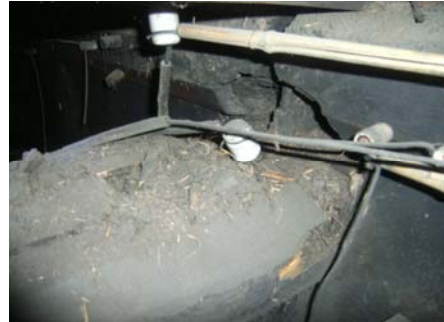
写真 6. 6. 2-2 大黒柱上端に連結する桁材における甲虫類による食害（左）と腐朽（右）
