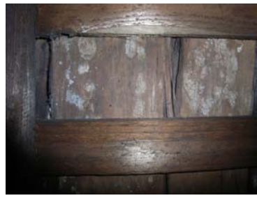
写真 6. 6. 2-14 小屋組（左）、野路板に見られる菌糸様付着物（右）
