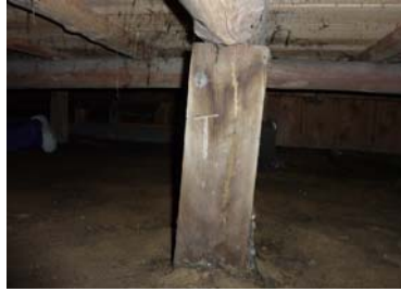
写真 6. 6. 2-11 浴室入口柱の蟻道（左）、床束の蟻道（中）、基礎の蟻道（右）
