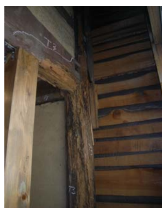
写真 6. 6. 2-26 玄関土間の柱など構造部材のシロアリ食害
