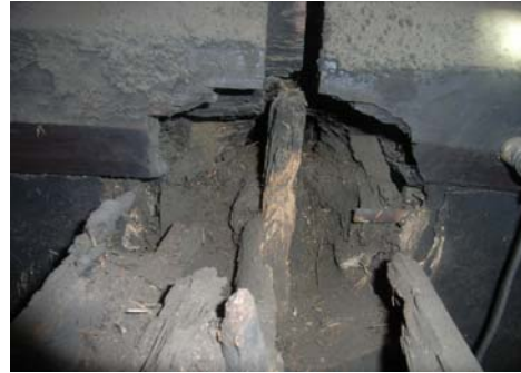
写真 6. 6. 2-1 大黒柱上端と梁との交差部における虫害と腐朽の状況
