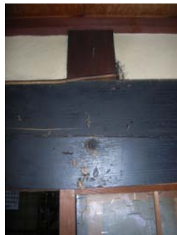
写真 6. 6. 2-8 同上差鴨居に発生した亀裂（左）と甲虫類による食害痕跡（右）
