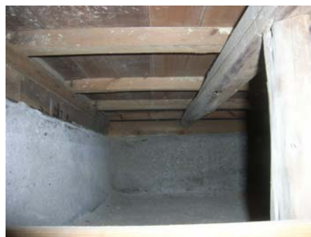
写真 6. 6. 2-18 床下の状況（乾燥している）
