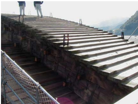
写真 6. 6. 4-10 改修工事中の錦帯橋の床版
