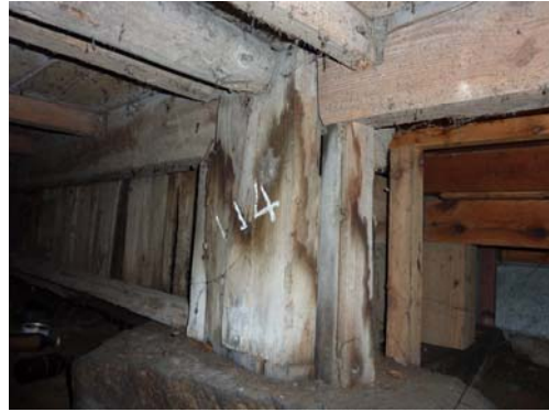
6. 6. 2-6 床束の腐朽（左）と大黒柱の足元における結露水によるシミ・腐朽（右）
