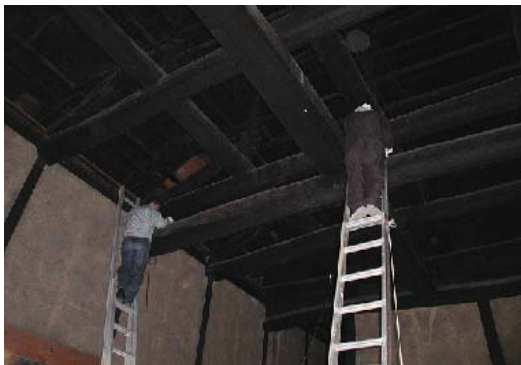
写真 6. 7. 2-1 調査建物例（興国寺改修前）
