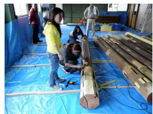
写真 6. 7. 2-6 光念寺丸柱の解体後調査
