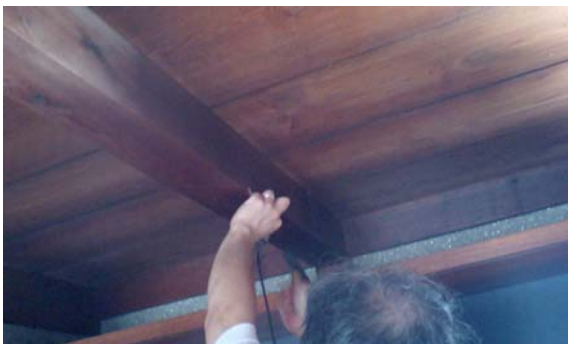
写真 6. 7. 3-13 三重古民家(5) 梁の測定
