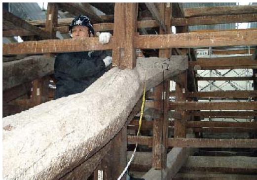
写真 6. 7. 2-3 調査建物例（善光寺山門改修中）
