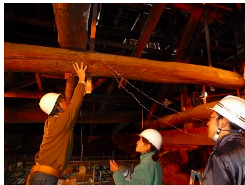
写真 6. 7. 3-8 ひずみの測定
