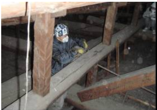
写真 6. 7. 3-3 小屋梁の測定の様子
