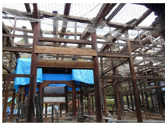
解体中の玄江院
