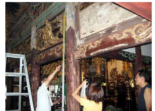
写真 6. 7. 2-5 光念寺内陣の解体前調査
