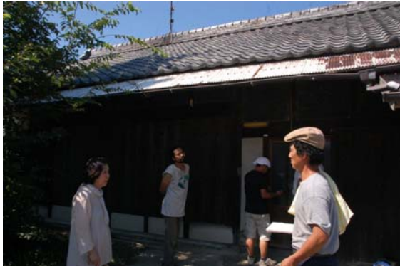
写真 6. 7. 3-9 三重古民家(1) 外観
