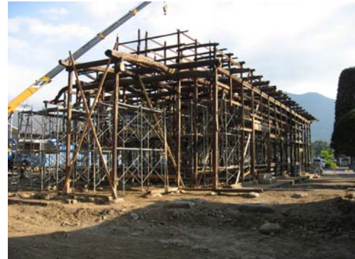
写真 6. 7. 2-2 調査建物例（興国寺改修中）
