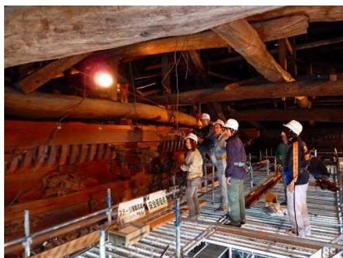
写真 6. 7. 3-7 萬善堂小屋組解体前調査
