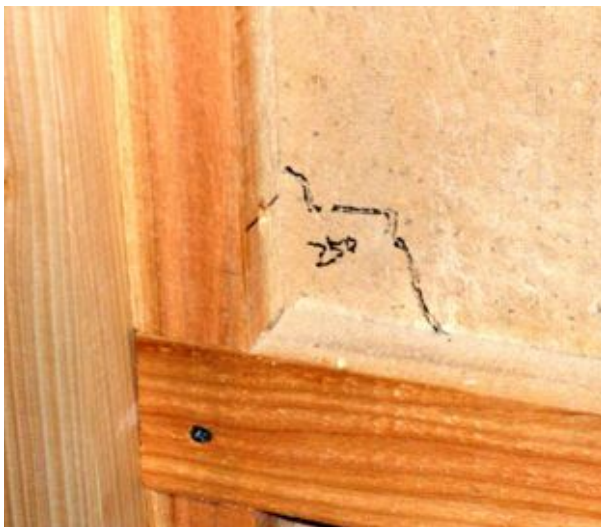
写真3.3.3-5 250cm/s 2 で発生した亀裂
