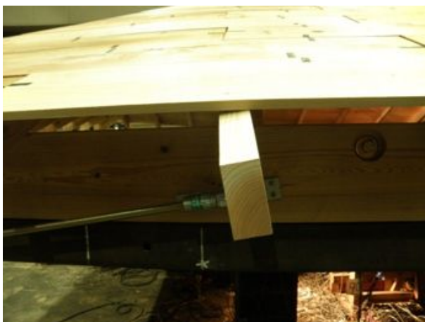
垂木－桁接合部（大平面）
