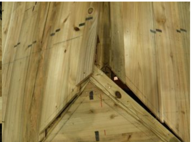
野地板の隅木、棟木の継ぎ目
