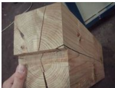
写真3. 4. 2-99 E1-2損傷状況
