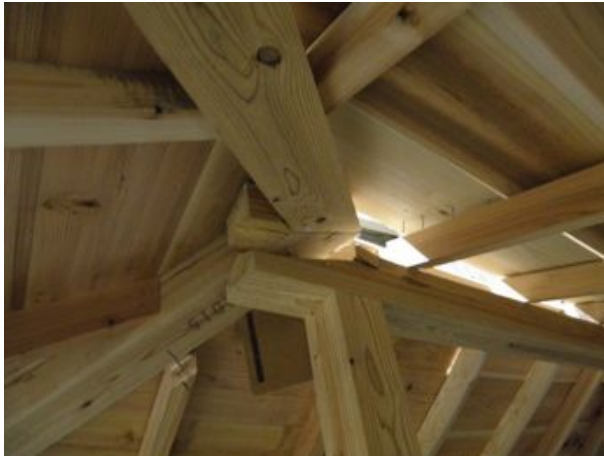
隅木－棟木接合部
