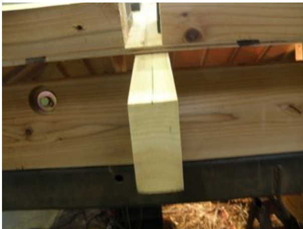
垂木一桁接合部（大平面）
