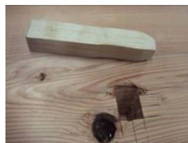
写真3.4.2-97 d' 1-4損傷状況
