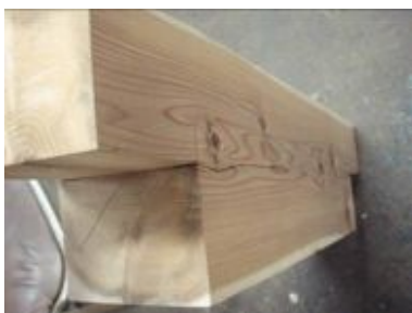
写真3. 4. 2-110 E1-13損傷状況
