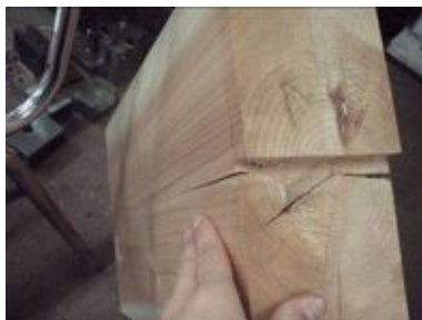
写真3. 4. 2-101 E1-4損傷状況
