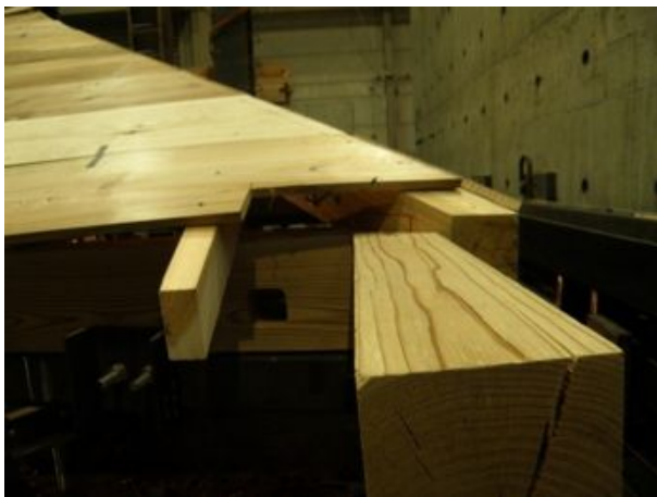
隅木－桁接合部
