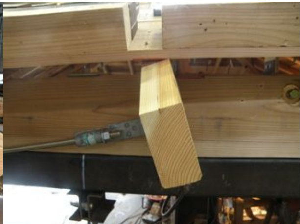
垂木一桁接合部
