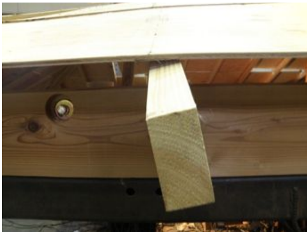
垂木－桁接合部（大平面）
