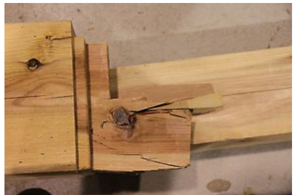
写真3. 4. 2-70 楔先端からホゾが損傷 (J4-6-2)
