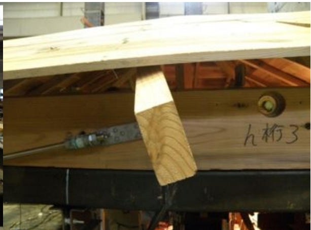
垂木一桁接合部
