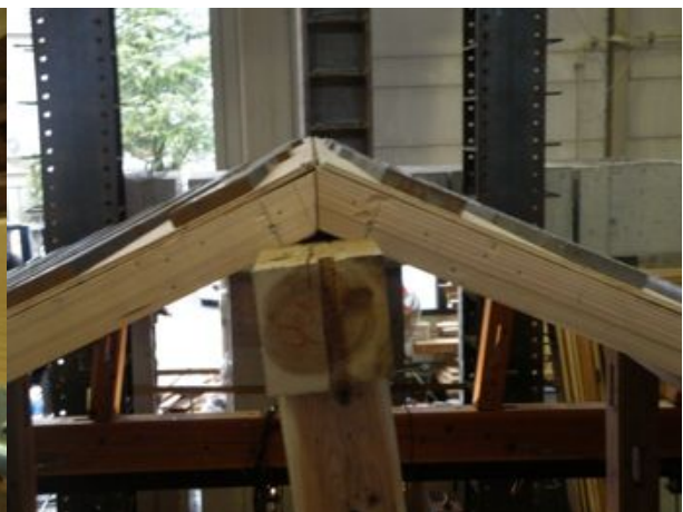
垂木－棟接合部
