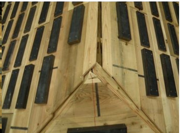
野地板の隅木、棟木の継ぎ目
