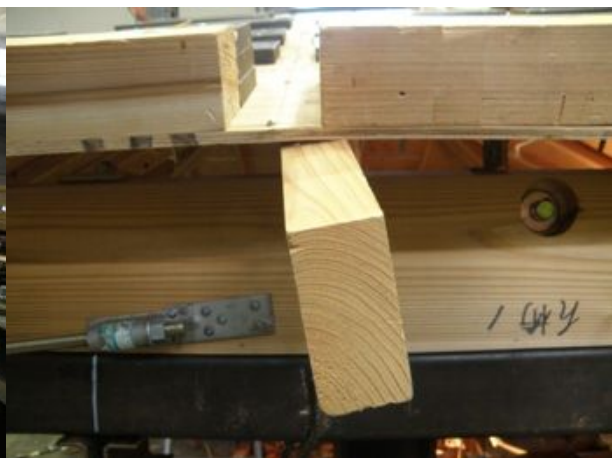
垂木一桁接合部
