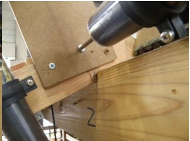
垂木－棟接合部
