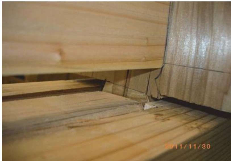
写真3. 5. 2-9 吊束下部の割れ (MWDF-11、1/10rad)
