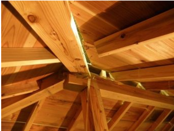
隅木－棟木接合部
