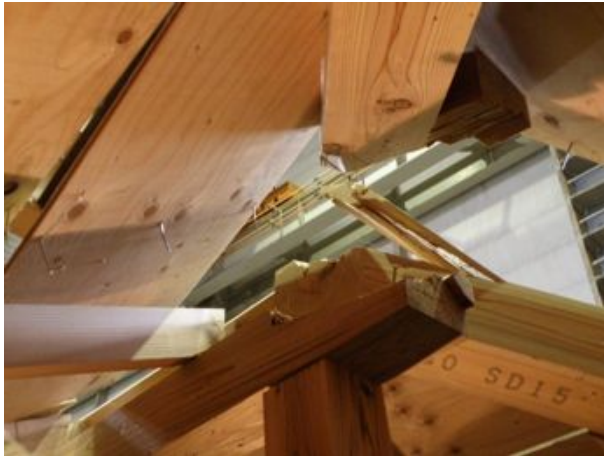
隅木－棟木接合部
