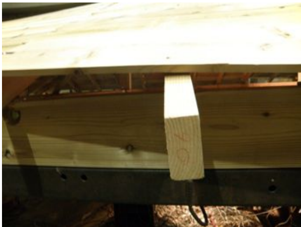
垂木一桁接合部（大平面）
