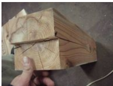
写真3. 4. 2-98 E1-1損傷状況
