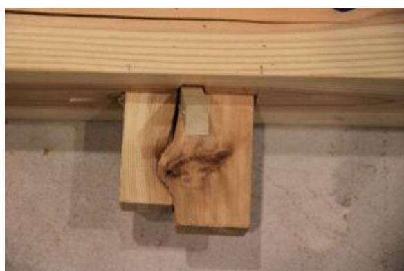
写真3. 4. 2-56 鼻栓から節へ亀裂が生じて破壊 (J2-5-2)
