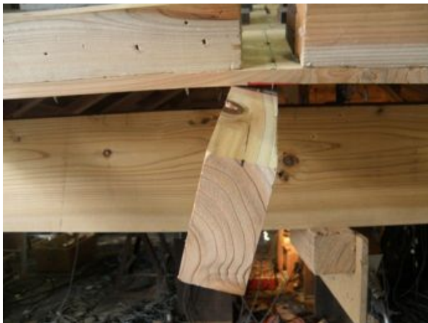
垂木一桁接合部
