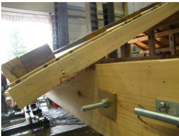
垂木－桁接合部
