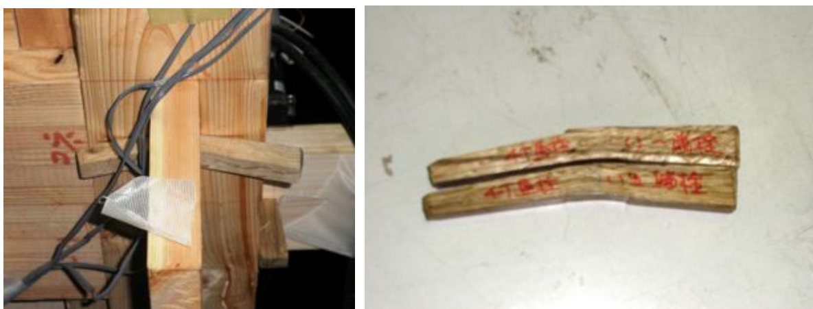
写真3.3.3-11 鼻柱の損傷状況（左：解体前、右：解体後）
