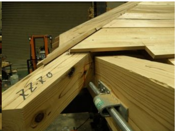
隅木－桁接合部
