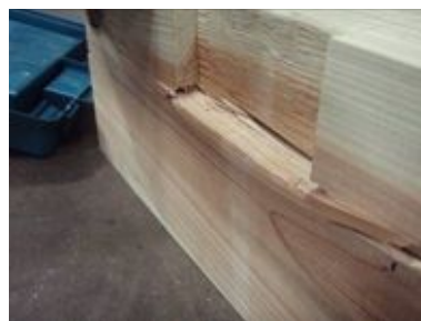
写真3. 4. 2-113 E2-3-5損傷状況
