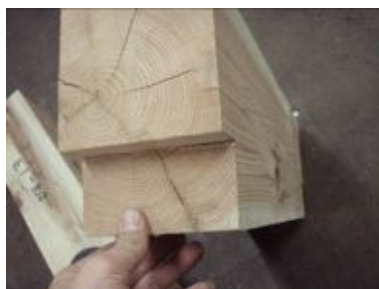
写真3. 4. 2-105 E1-8損傷状況
