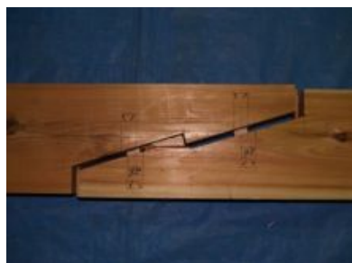
鎌部分のせん断破壊
