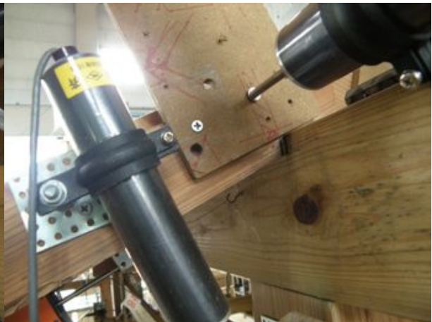
垂木－棟接合部
