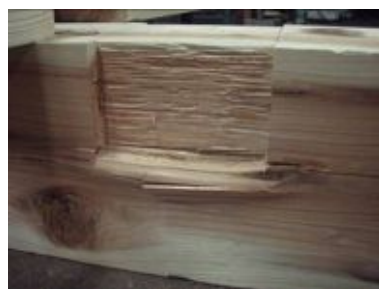
写真3. 4. 2-114 E2-4-2損傷状況
