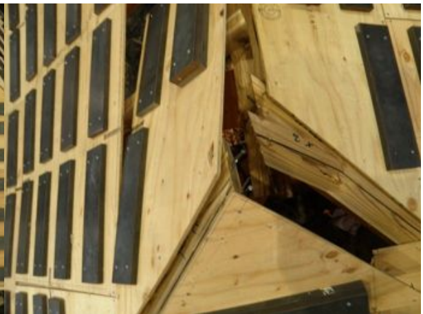
野地板の隅木、棟木の継ぎ目
