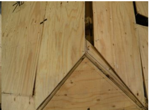
野地板の隅木、棟木の継ぎ目
