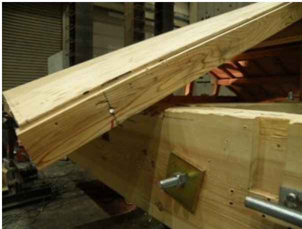
垂木－桁接合部
