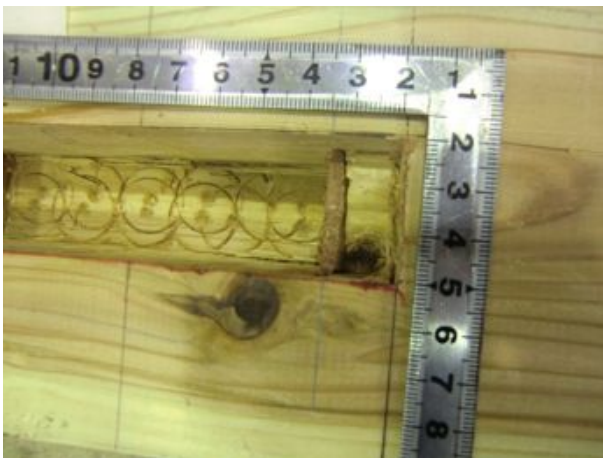
写真3. 4. 2-41 J1No6-2加力後 柱ほぞ孔
