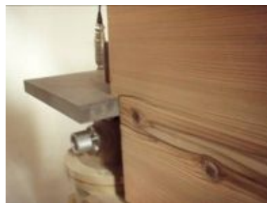
写真3. 4. 2-100 E1-3損傷状況
