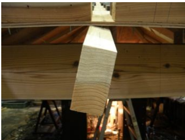
垂木一桁接合部
