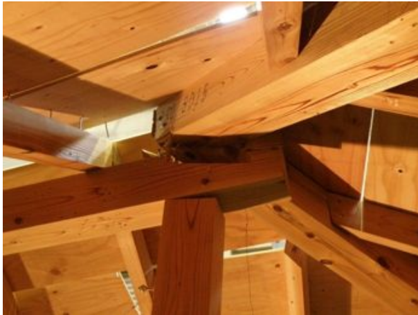
隅木－棟木接合部
