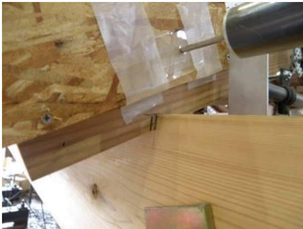
垂木－桁接合部
