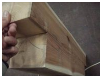
写真3. 4. 2-109 E1-12損傷状況
