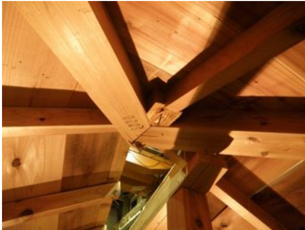
隅木－棟木接合部
