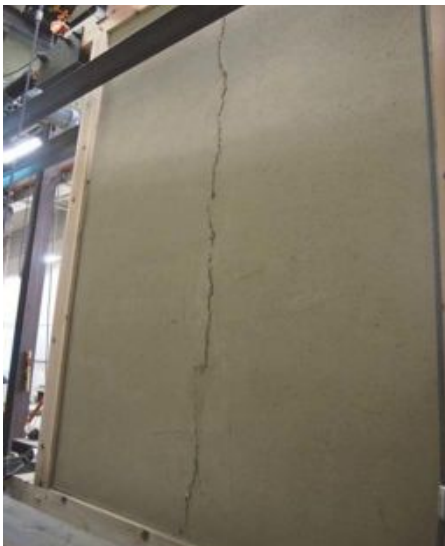
(a) 1/90rad 縦貫位置の亀裂
