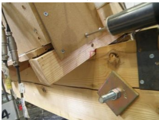
垂木－桁接合部
