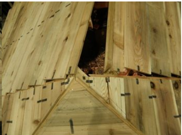
野地板の隅木、棟木の継ぎ目
