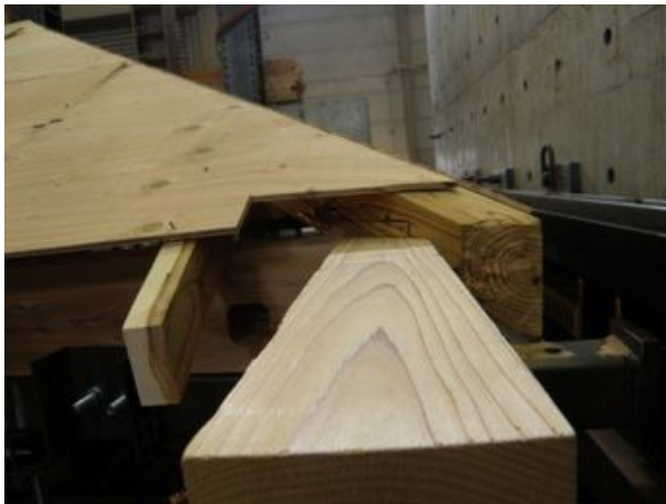
隅木－桁接合部
