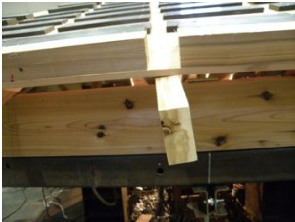
垂木一桁接合部（大平面）
