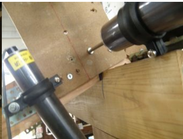
垂木－棟接合部
