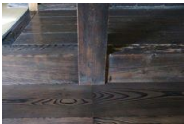
写真 4. 2. 13-11 柱と差框の取り合い
