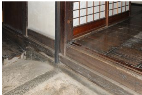
写真4.2.11-6 「とおりにわ」「みせ」境の土台廻り。右端に床面換気口が見える。
