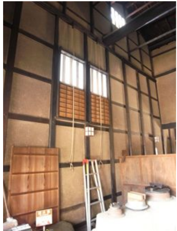
写真4. 2. 7-2 通り土間 妻壁
