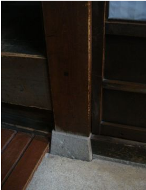
写真4. 2. 3-12 礎石の上に立つ柱と足固め
