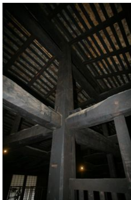
写真4. 2. 17-4 吹き抜け大黒柱棟持ち柱
