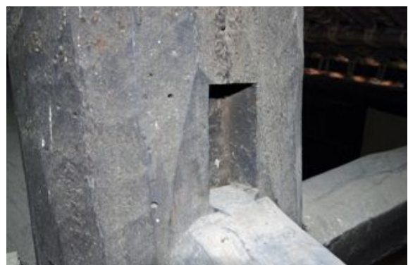
写真4. 2. 18-22 土間境棟持柱中引梁蟻落とし
