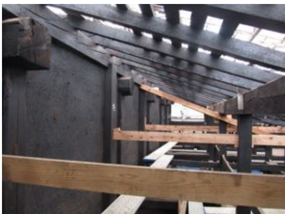
写真4. 2. 6-40 背面棟中央3間小屋梁母屋折置
