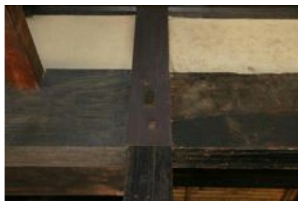
写真 4. 2. 13-12 柱と差鴨居（無目鴨居）の取り合い
