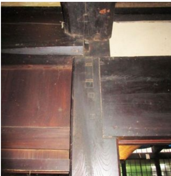
写真4. 2. 6-28 差鴨居ホゾ差し込栓止め
