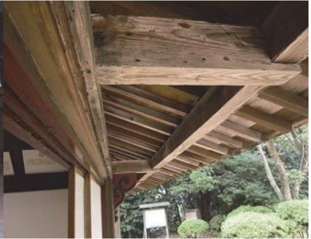
写真4. 2. 10-8 出桁の状況
