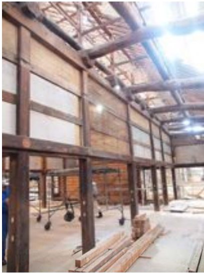
写真4. 2. 2-7 柱頭繋ぎ敷桁と軸組
