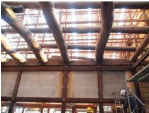
写真4. 2. 2-9 梁を井桁に組む
