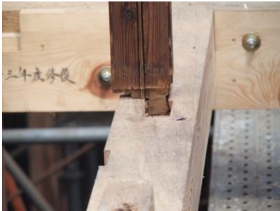
写真4. 2. 6-31 二階柱根寄せ蟻
