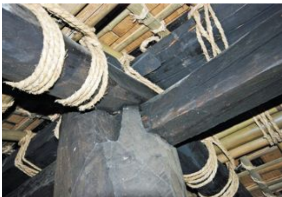
写真4. 2. 18-19 棟持柱上叔首・敷棟
