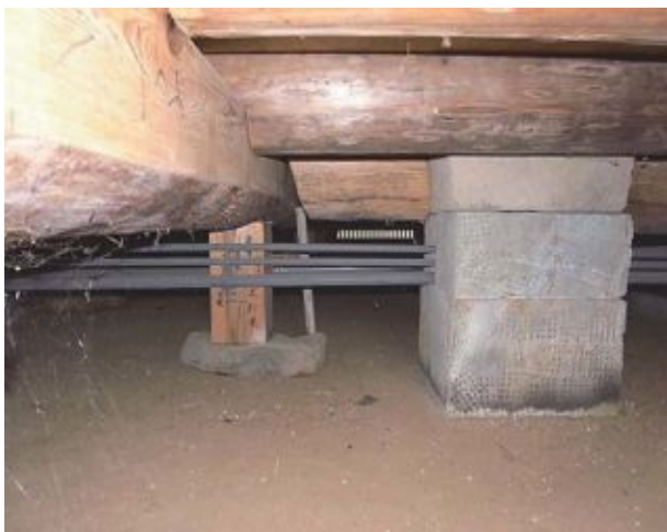
写真4. 2. 10-11 1階床下 大引は一間ごとに入り 300角～240角の丸太 材質は松
