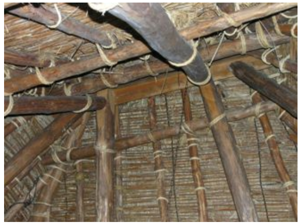
写真4. 2. 16-4 真島家小屋裏又首構造
