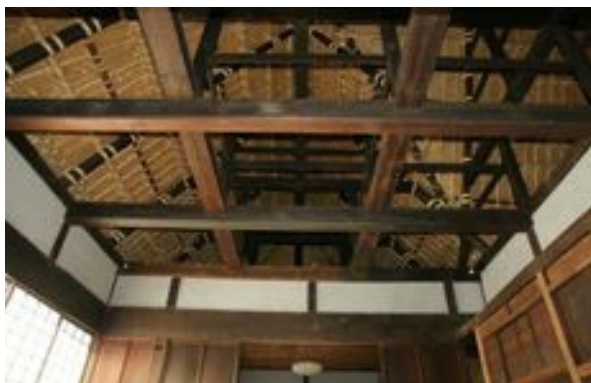
写真 4.2.13-5 「アラケ」小屋組見上げ
