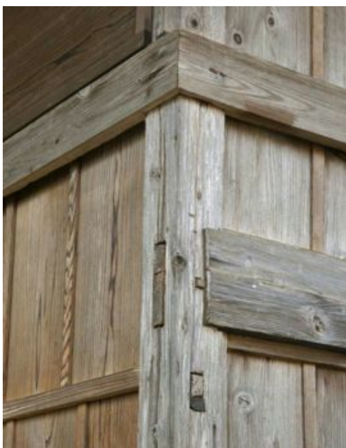
写真 4. 2. 13-13 柱と出入り口鴨居の取り合い
