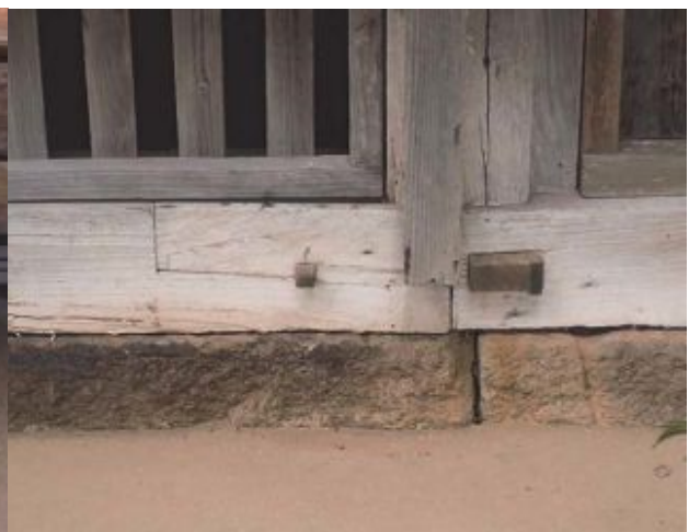
写真4. 2. 10-12基礎 足元の様子 延石は五箇石（凝灰質砂岩） 土台の材質は椎、栗、杉 継手は尻ばさみ
