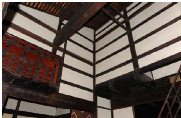
写真4.2.11-4 「かんざ」北東隅見上げ
