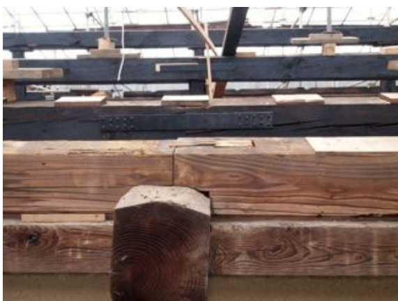
写真4. 2. 6-37 軒桁継手7寸鎌継
