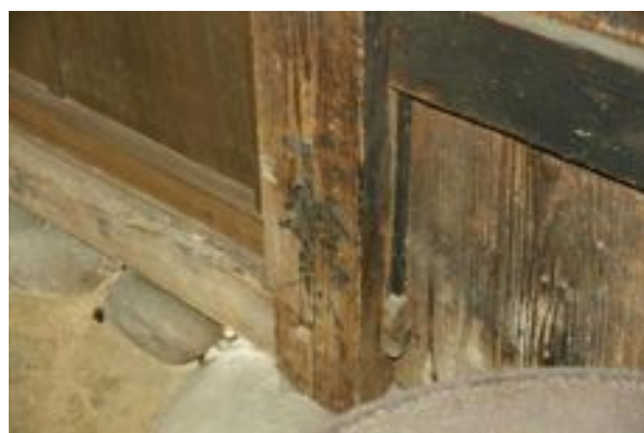
写真 4. 2. 13-14 柱と出入り口敷居の取り合い
