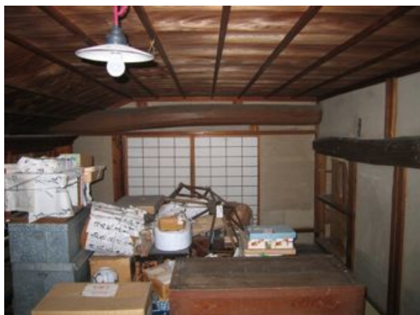
写真4. 3. 3-4 2階居室部分建物内観
