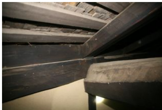
写真4. 2. 17-10 折置梁に桁が渡腮に掛り 垂木約10m135×150が910ピッチで掛る
