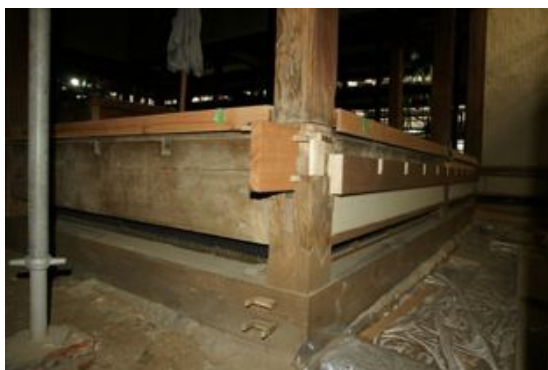
写真4. 2. 12-2 南西隅足元 (下が土台、隙間を空けて上に足固)
