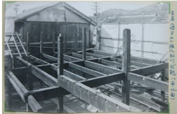
写真4.2.4-15 修理時の記録写真・差鴨居、胴差
