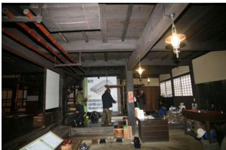
写真4. 2. 17-3 土間空間2階床梁組
