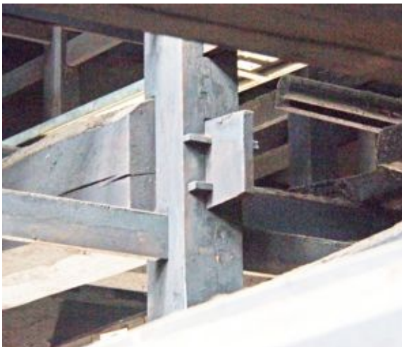
写真4. 2. 6-30 胴梁ホゾ打ち出し鼻栓止め
