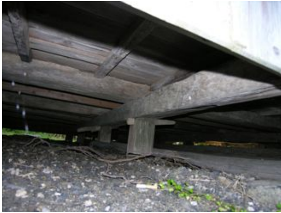
写真4. 2. 16-3 真島家床下足固め
