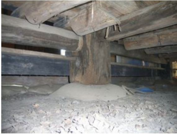
写真4. 2. 18-5 どま棟持柱足元、 上が框と足固大引
