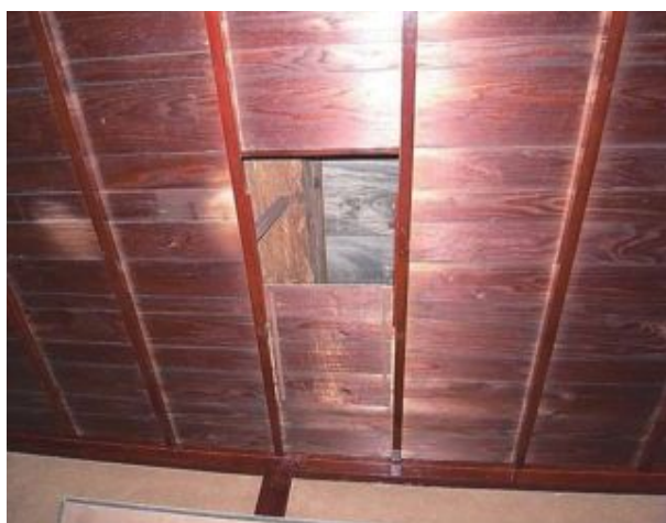
写真4. 2. 10-13 天井 二重天井 天井裏に丈夫な床板が張ってある
