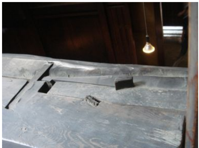
写真4. 2. 3-14 大黒柱 二方差し竿車知栓
