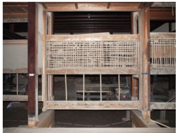
写真4. 2. 6-7 大座敷壁下地
