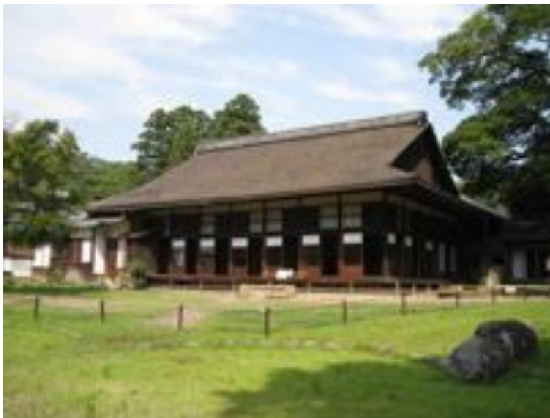
写真4. 2. 12-1 御書院棟外観（東面） 修理前 2
