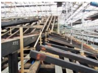
写真4. 2. 6-21 正面棟棟木、垂木、背面棟との取り合い
