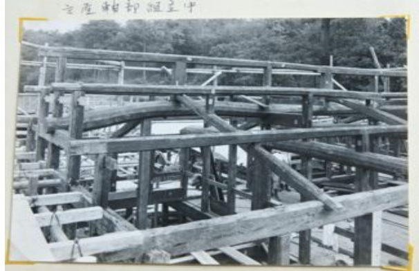
4.2.4-13 修理時の記録写真・小屋組
