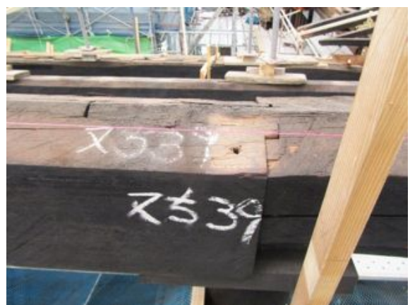
写真4. 2. 6-38 棟木継手7寸鎌継
