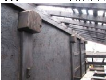
写真4. 2. 6-23 正面棟棟木、母屋
