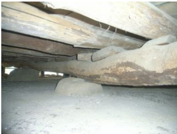
写真4. 2. 18-7 大引を直接束石で受ける
