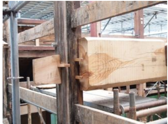
写真4. 2. 6-32 胴梁ホゾ打ち出し込栓および鼻栓打ち
