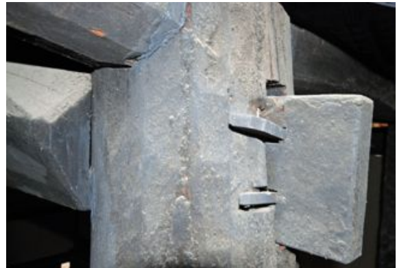
写真4. 2. 18-18 差梁大根込栓止め
