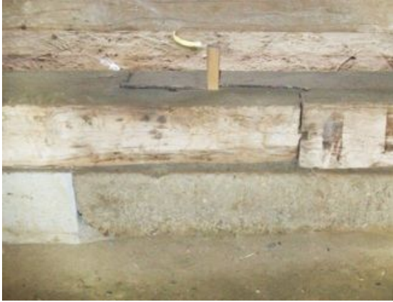
写真4. 2. 6-26 土台継手金輪継
