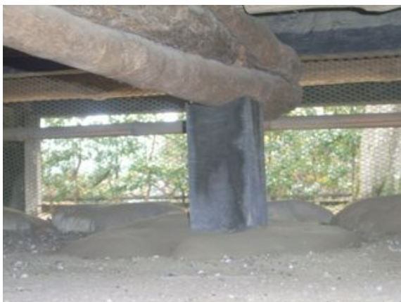
写真4. 2. 18-9 大引を側廻り通り 芯より内側で受ける
