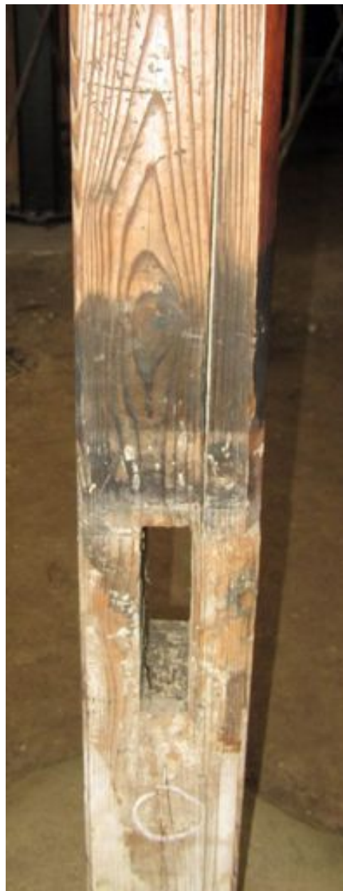
写真4. 2. 6-41 大座敷柱背割れ、足固ホゾ穴
