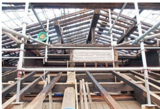
写真4. 2. 6-25 背面棟の小屋組
