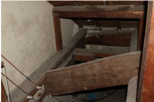
写真4.2.5-9 桔梁をいれ桁荷重を受けている
