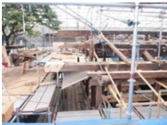
写真4. 2. 6-22 正面棟棟木、母屋
