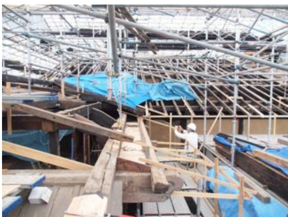
写真4. 2. 6-24 正面棟と背面棟の小屋の取り合い
