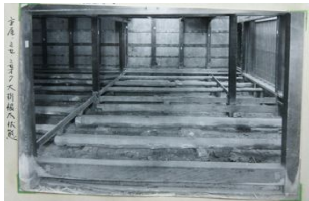
写真4.2.4-17 修理時の記録写真・床組
