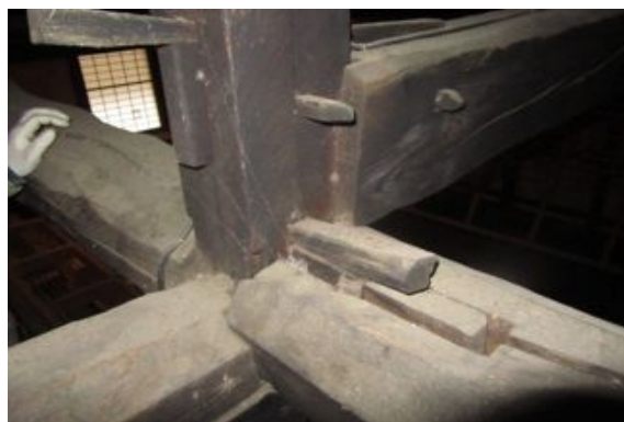
写真4-2-17-12 棟持ち大黒柱と梁組
