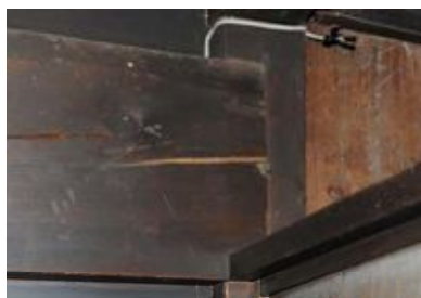
写真4.2.11-11 継手・仕口
