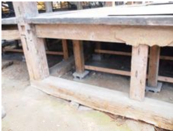
写真4.2.2-3 大広間土台+足固め
