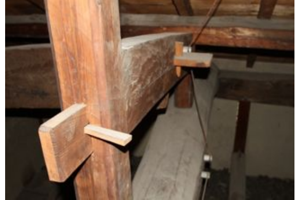
写真4.2.5-10 桔梁（左図）を受ける飛梁
