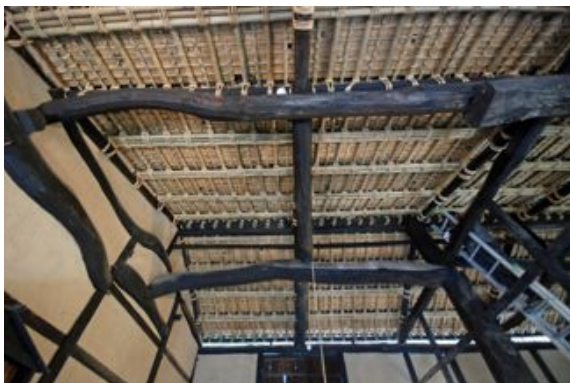
写真 4. 2. 18-15 土間上小屋梁
