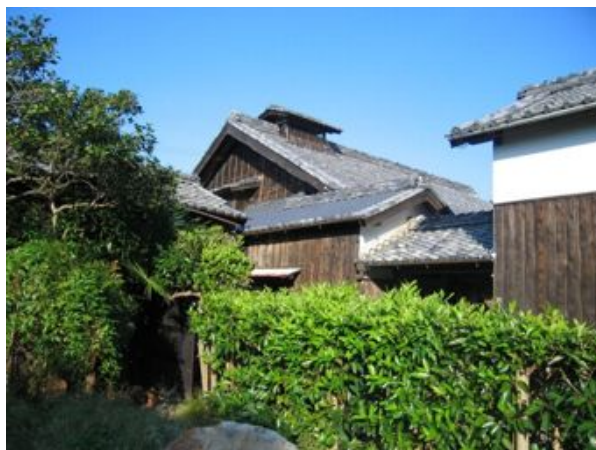
写真4. 3. 3-2 張り間方向建物外観
