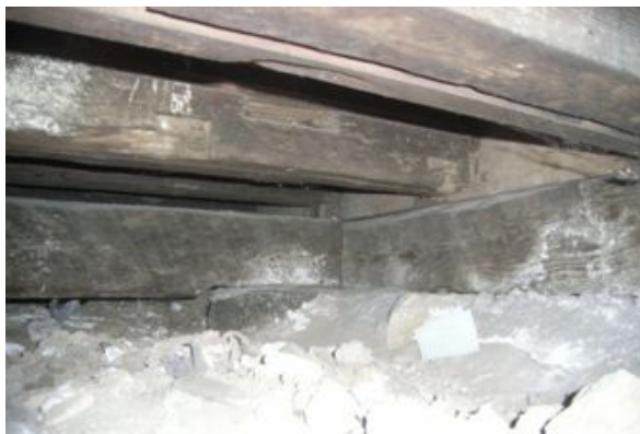
写真4.2.11-7 「じょい」床下の状況。南東隅を見る。
