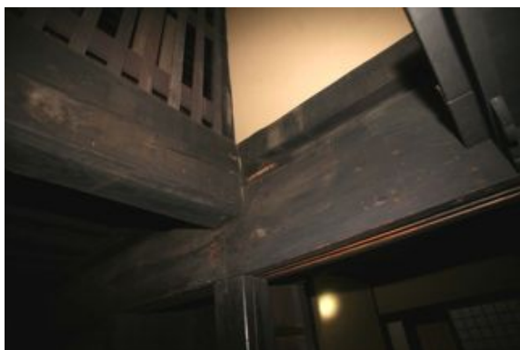
写真4-2-17-11 差鴨居と梁の取り合い
