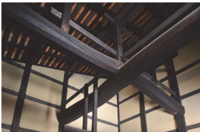
写真4. 2. 14-4 帳場の小屋組（撮影／麓和善）
