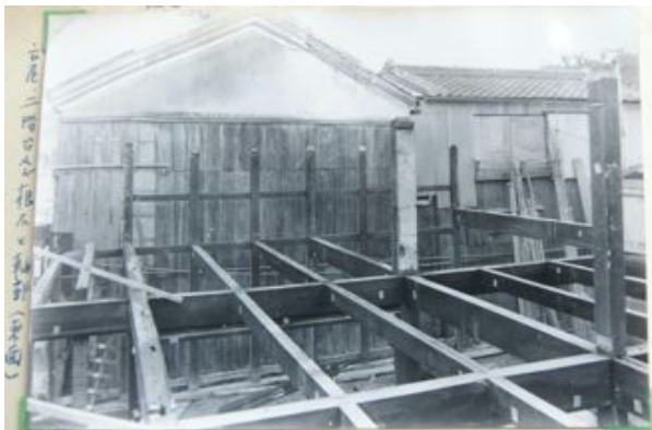
写真4.2.4-16 修理時の記録写真・差鴨居
