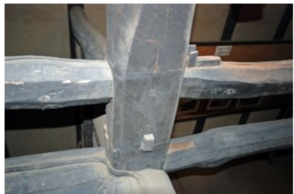
写真4. 2. 18-20 土間柱両差棹車知継
