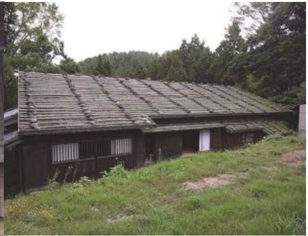
写真4. 2. 10-2 屋根 杉皮葺三枚重ね 割竹を渡し、その上は置石
