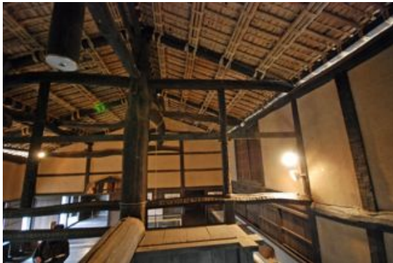
写真4. 2. 18-13 土間境背面小屋梁組
