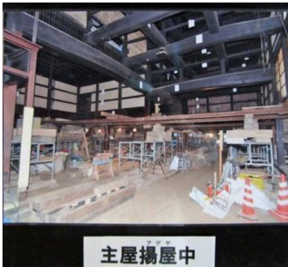
写真4. 2. 6-4 通り土間軸組 (文化財建造物保存技術協会展示パネルより)
