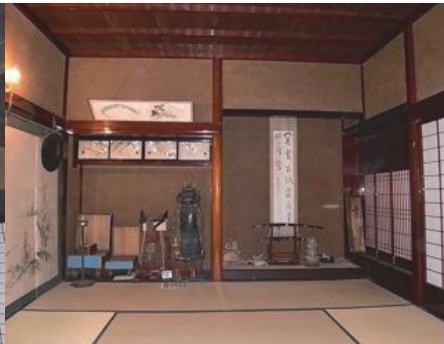
写真4. 2. 10-10 室内 代表的な部屋 床の間のある座敷 竿縁天井（板は杉白太のみで樋部倉矧ぎとしている）
