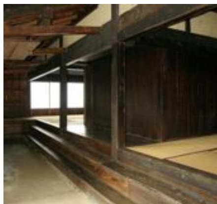
写真 4. 2. 13-10 土間、床上部境の状況
