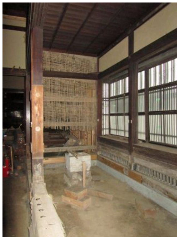
写真4. 2. 6-11 勘定の間土間十足固貫
