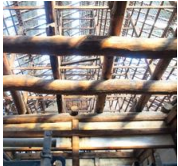
写真4. 2. 2-8 梁間方向の丸太梁
