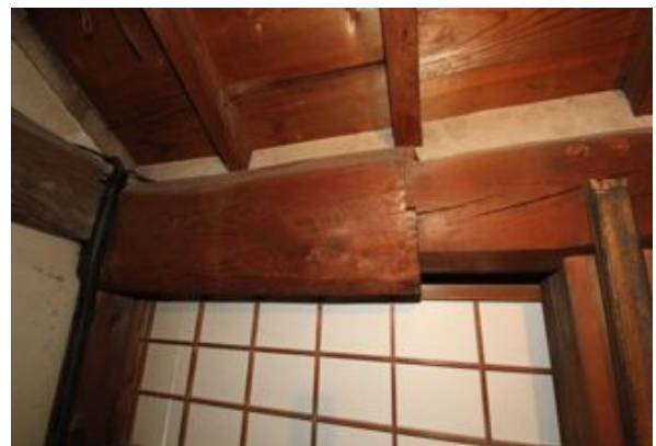
写真4.2.5-12 桁繋ぎ、持ち出し腰掛け鎌継ぎ
