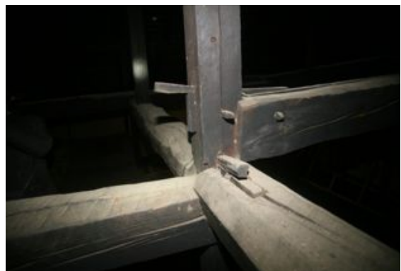
写真4.2.17-8 棟持ち柱に取り付く梁組
