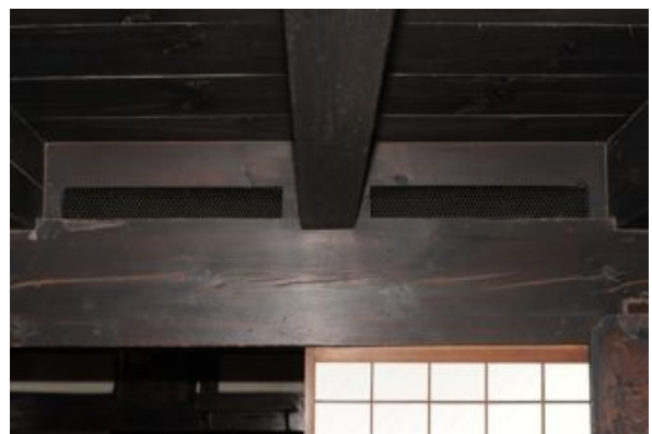
写真4.2.11-8 「みせ」「かんざ」境の換気口
