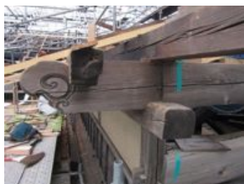
写真4. 2. 6-17 敷桁、出梁、軒桁
