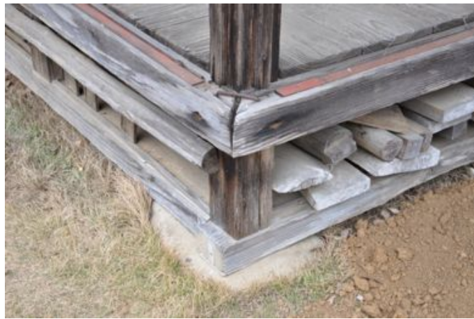
写真4.3.4-2 木内家住宅 柱脚の納まり
