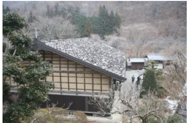
写真4. 2. 17-2 西面山側より石置き屋根を見る
