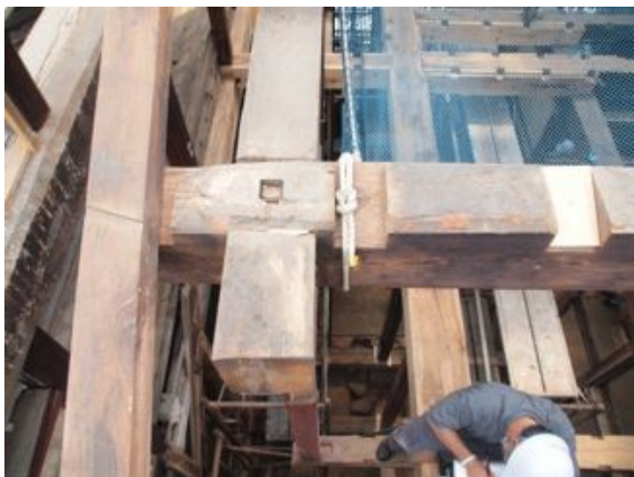
写真4. 2. 6-33 軒桁、出梁、化粧垂木仕口
