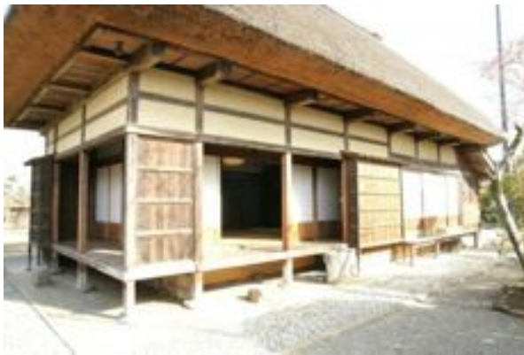
写真 4.2.13-3 「ザシキ」縁外観
