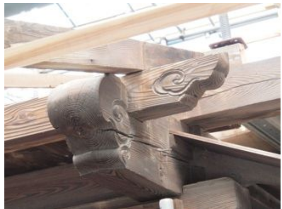
写真4. 2. 6-34 軒桁、出梁渡顎組と繰形
