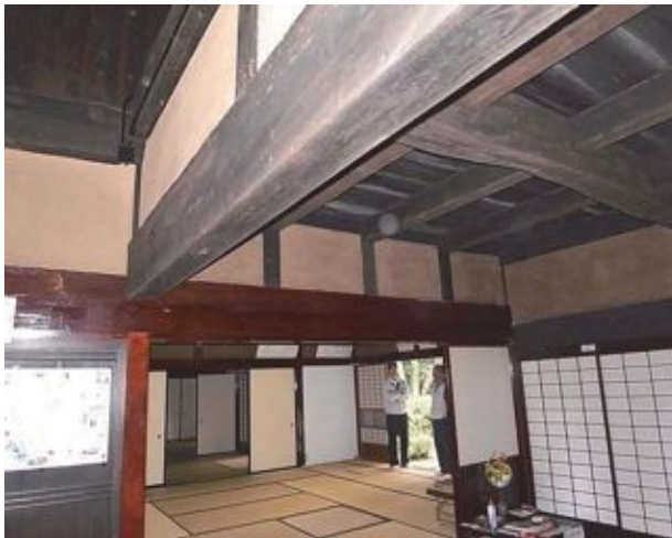
写真4. 2. 10-9 通り梁 一本通り360x180 長さ11.2m 材質は松
