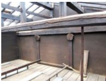
写真4. 2. 6-20 正面棟小屋梁
