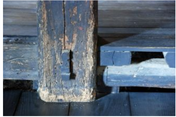
写真4. 2. 18-24 根太ホゾ差し、 足固大引き、上框同士鎌継
