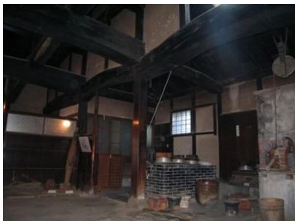
写真4. 3. 3-3 1階土間部分建物内観
