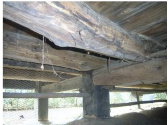
写真4. 2. 18-8 柱に刺さる大引と縁廻り地貫
