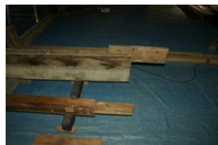
雇い材仮入れ状態
