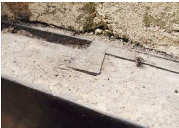
写真4. 2. 6-39 差鴨居背割れ止めチギリ打ちこみ
