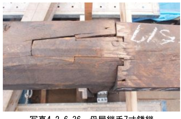
写真4. 2. 6-36 母屋継手7寸鎌継
