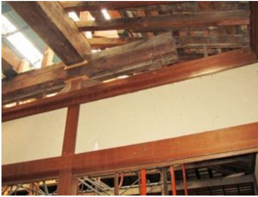
写真4.2.6-15 大座敷上の出梁と中引梁
