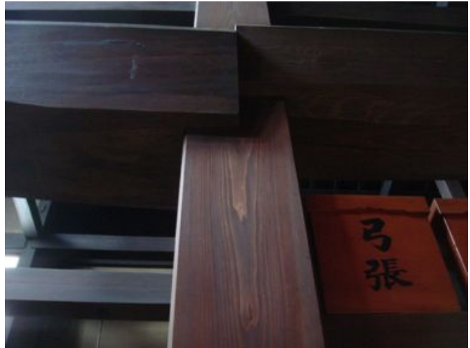
写真4. 2. 3-13 大黒柱に組まれた梁
