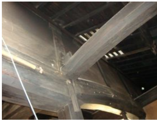
写真4. 2. 5-4 梁は柱に竿車知、込み栓、鼻栓等で
