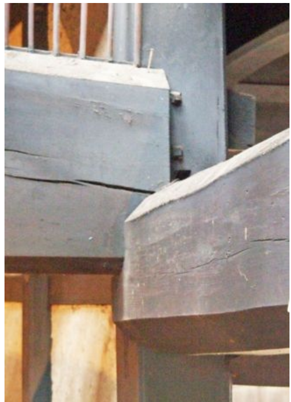
写真4. 2. 6-29 胴梁小根打ち出し込栓止め
