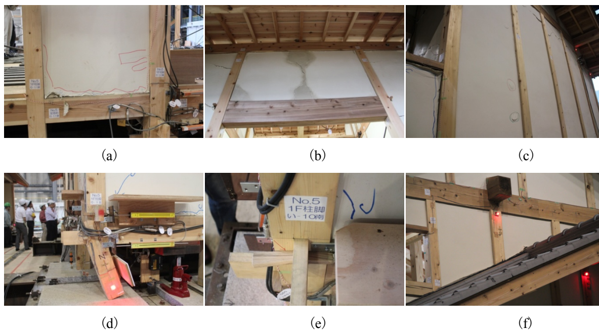
写真 2.3.2-13 JMA-Kobe 波加振による試験体 No.5 各部の損傷
