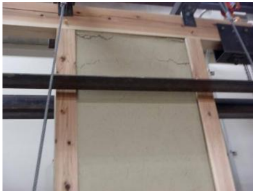
(i) 表面の上貫付近の亀裂の進行(1/30)
