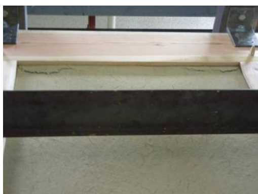
(f) 大きくなった裏面のチリ付近の亀裂(1/60)
