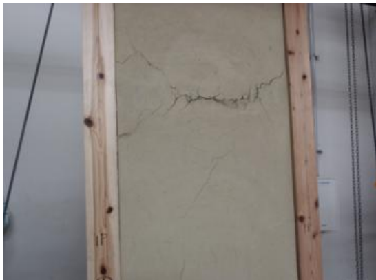
(i) 中貫付近の亀裂の進展 (1/20)
