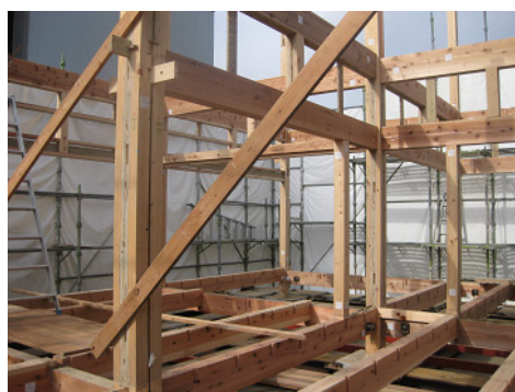
写真 3.2.2-62 軸部解体
