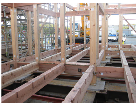
写真 3.2.2-61 軸部解体
