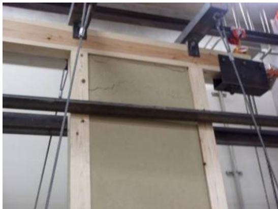
(i) 表面の上貫付近の亀裂の進行(1/45)
