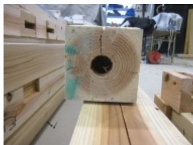
(k) 柱底面のだぼ穴
