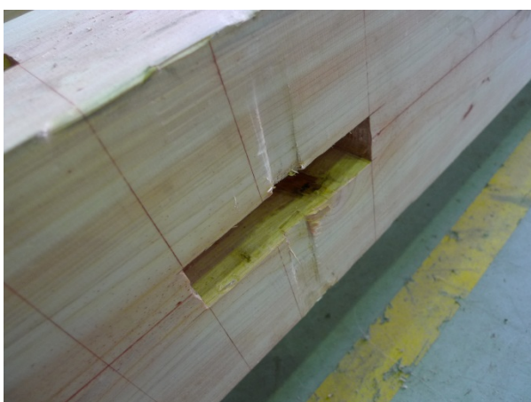
写真 3.3.2-20 柱一胴差接合部のめり込み痕
