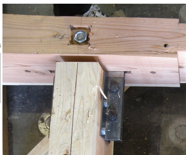
写真 3.4.1-1 桁端部接合
