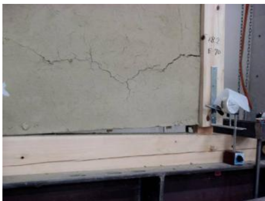
(o) さらに大きくなった表面の亀裂 柱、間渡しの抜け(1/15)
