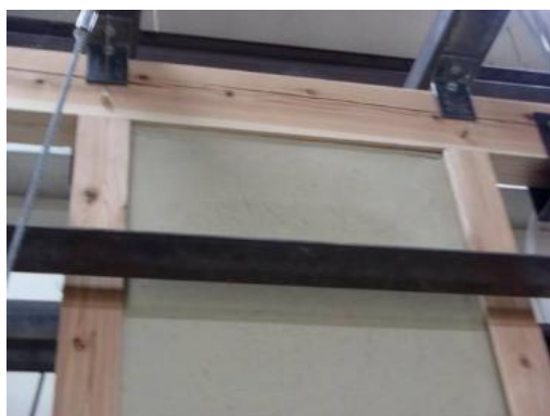
(c) 表面に生じたチリ付近の亀裂(1/90)
