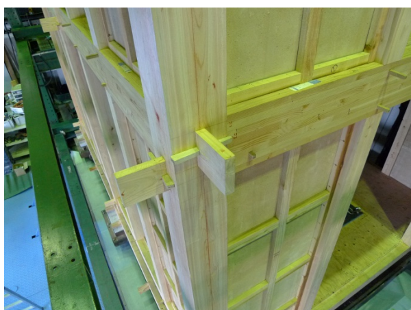
写真 3.3.2-8 通し柱一胴差接合部
