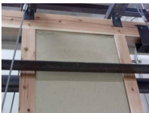
(e) 大きくなった表面のチリ付近の亀裂(1/60)
