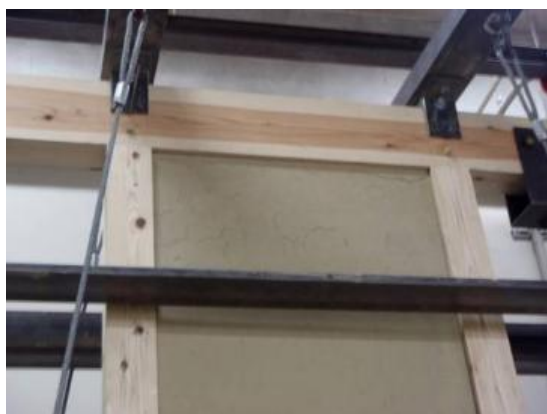
(c) 表面の上貫、チリ付近の亀裂(1/90)
