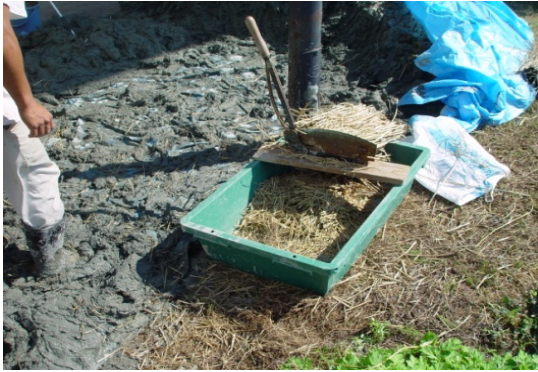
スサの混入と押切りによる切断
