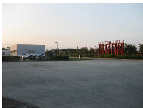
写真 3.2.2-66 架台解体完了
