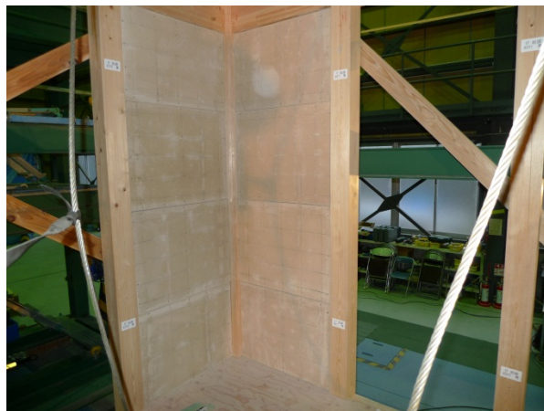
写真 3.3.2-13 実験終了時の乾式土壁パネル
