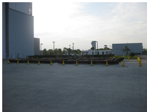
写真 3.2.2-64 軸部解体完了
