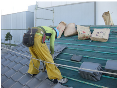
写真 3.2.2-59 屋根瓦解体
