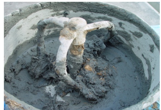
中塗土の練混ぜ(もみスサの混入)
