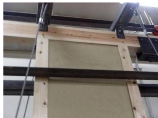
(d) 表面上貫付近の亀裂(1/90)
