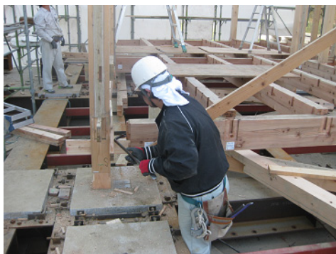
写真 3.2.2-63 軸部解体
