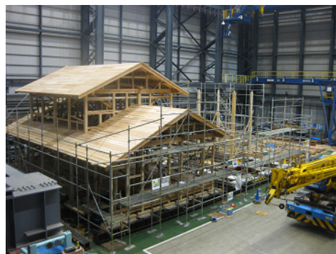
写真 3.2.2-20 NO.6 建方完了
