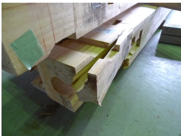
写真 3.3.2-18 解体後の柱底面(X1Y1)
