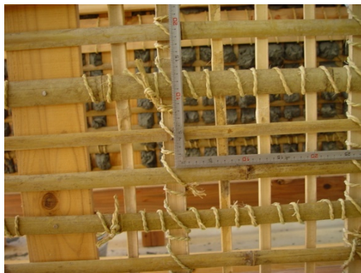
小舞間隔 (空き 40mm 角：縦 70×横 70mm)
