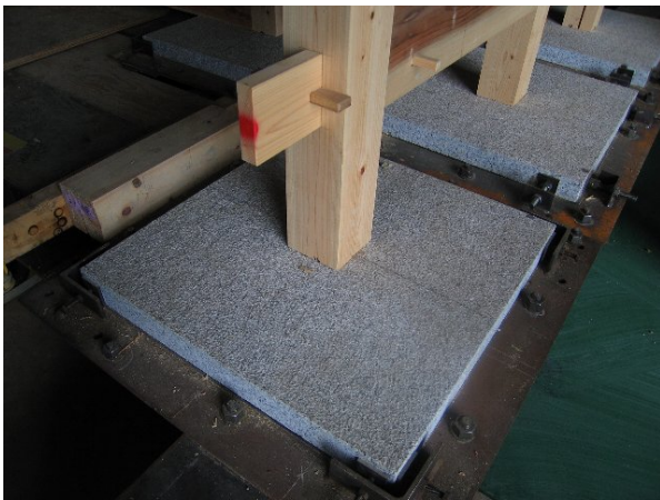
a) 試験体 No.5 柱脚(石場建て)
