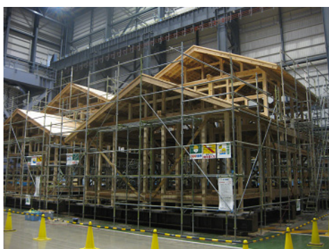
写真 3.2.2-23 NO.5 建方完了
