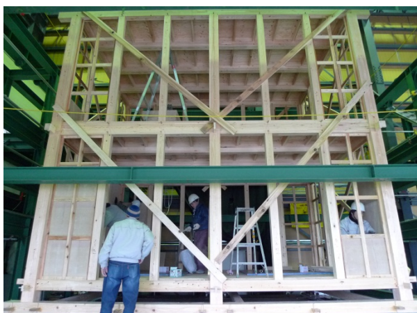
写真 3.3.2-4 乾式土壁パネルの施工
