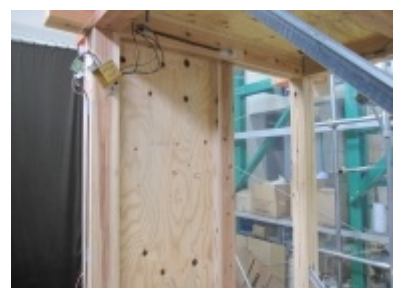
(o) 構造用合板の取り付け状況
