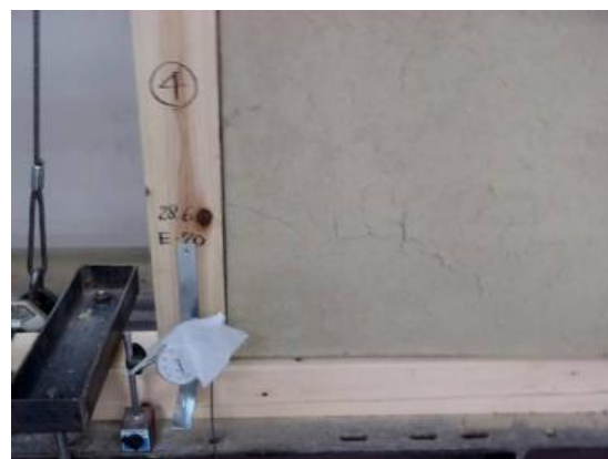
(d) 表面下貫付近に生じた亀裂 (1/90)
