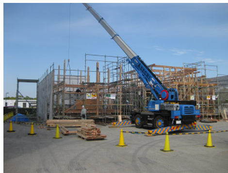
写真 3.2.2-60 軸部解体
