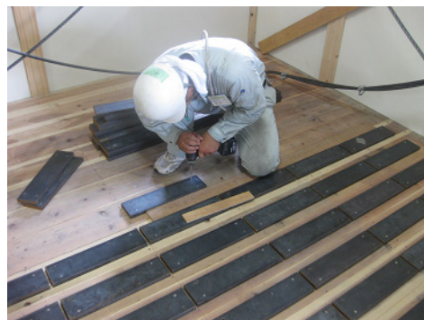
写真 3.2.2-48 錘鉄板設置
