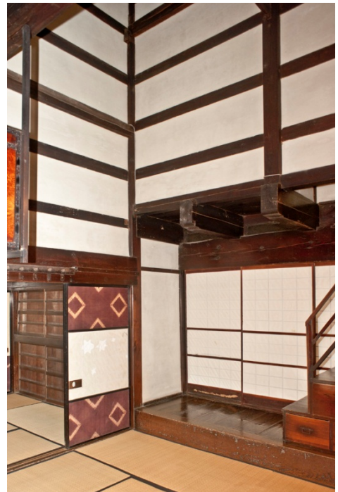
写真 4.2.2-63 重要文化財 旧中村家住宅 (盛岡市) 文久元年(1861) (盛岡市中央公民館協力)
