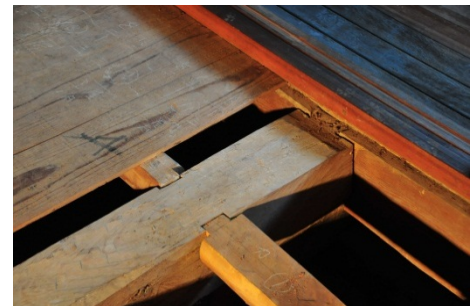
写真 4.2.2-60 重要文化財 上芳我家住宅 （愛媛県内子町）明治27年(1894)
