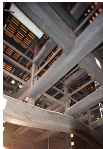
写真 4.2.2-4 同上 主屋小屋組
