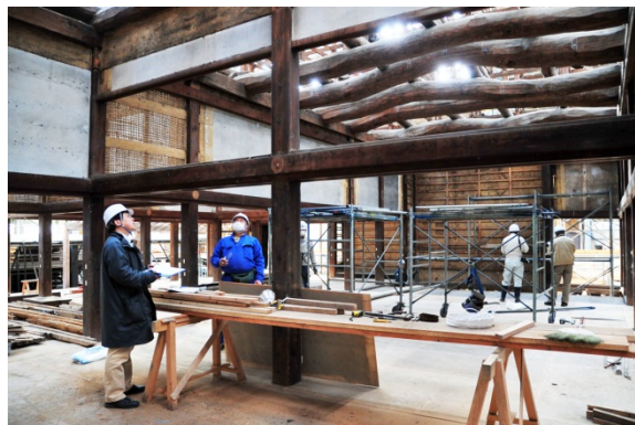
写真 4.2.2-9・10 重要文化財 勝興寺大広間(高岡市)
