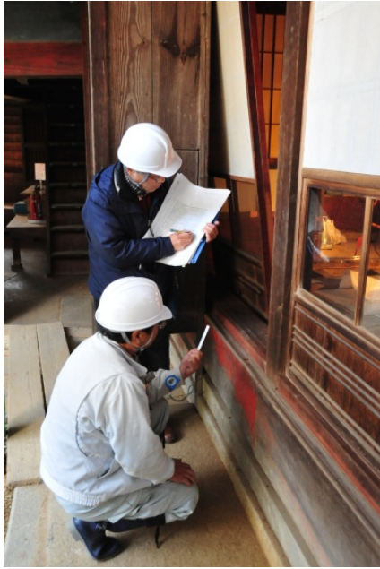
写真 4.2.2-56 重要文化財 上芳我家住宅（愛媛県内子町） 明治 27 年(1894)
