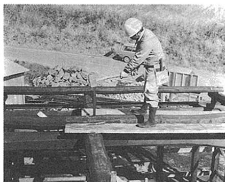
大栓は上部から掛矢で打ち込む
