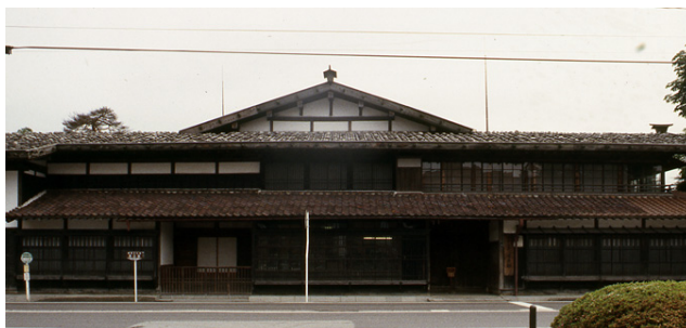
写真 4.2.2-3 重要文化財 渡邊家住宅 （新潟県関川村） 文化 14 年(1817)
