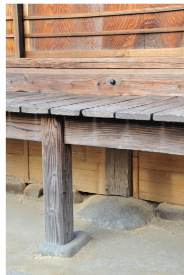
写真 4.2.2-49 重要文化財 太田家住宅（熊本県多良木町）江戸末期
