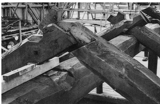
登り梁の押み仕口 納差し込栓で組まれた登り梁は、地棟に渡り腮で架かる。棟木は腰付鎌継で、登り梁の押みし渡り腮で載る。
