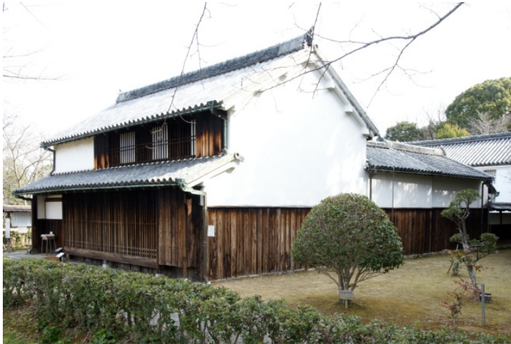
写真 4.2.2-24・25 重要文化財旧柳川家住宅(海南市) 文化4年(1807)
