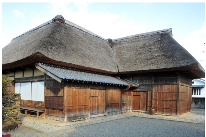
写真 4.2.2-44 重要文化財 太田家住宅 (熊本県多良木町) 江戸末期
