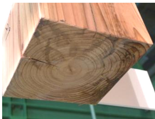
写真17 礎石・切り出し 柱底面
