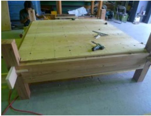
写真1 試験体の製作状況
