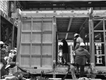
写真3 No.1 試験体の損傷観察風景
