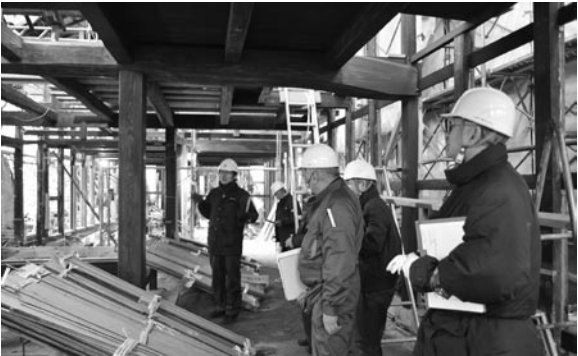
重要文化財 大村家住宅(愛媛県喜多郡内子町)
