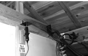
母屋継手ずれ（B－4）
