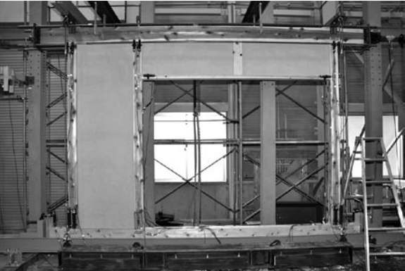
写真 1 MWD-10 設置状況
