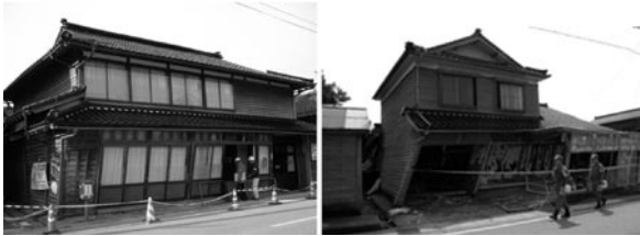
地震で1階が大きく変形した木造建物の被害例
