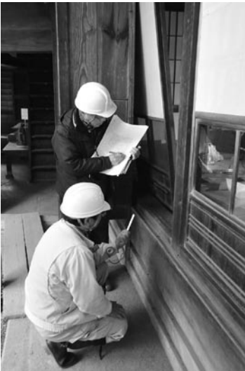
重要文化財 上芳我家住宅(愛媛県喜多郡内子町)
