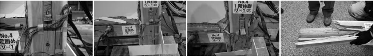
柱亀裂（A－4）
