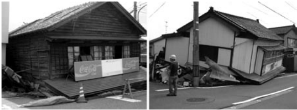
地震で1階が崩壊した木造建物の被害例
