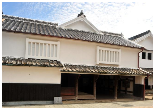
〔図 43〕 重要文化財 西岡家住宅（佐賀県塩田町） 安政 2 年(1855)
